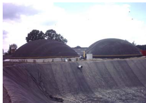
Digesteurs anaérobies avec un bassin de lagunage
