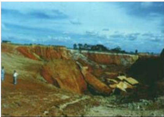
Dommages causés par l'érosion
