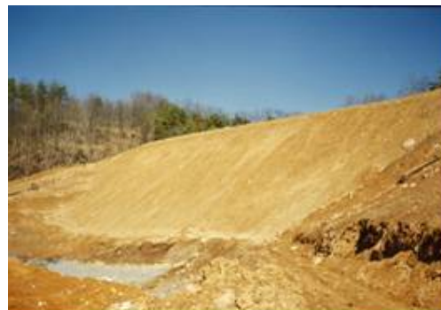
Remblai renforcé achevé
