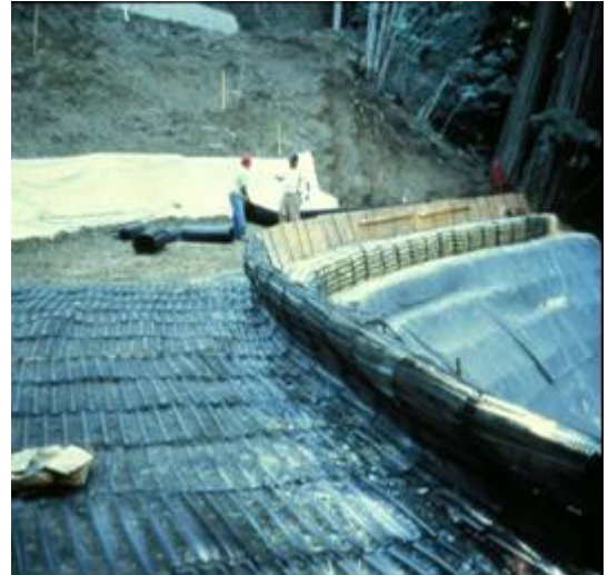
Exemple de réparation d'une pente par une structure de sol renforcée
