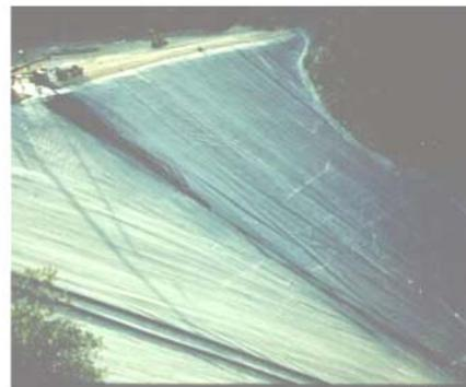
Etanchement d'un barrage par géomembrane\*
