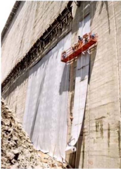
Etanchement du parement amont d'un barrage\*
