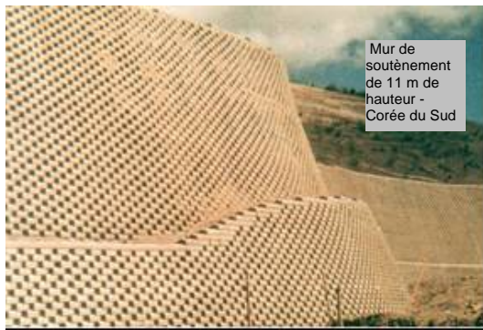
Massif à parement en blocs en béton
