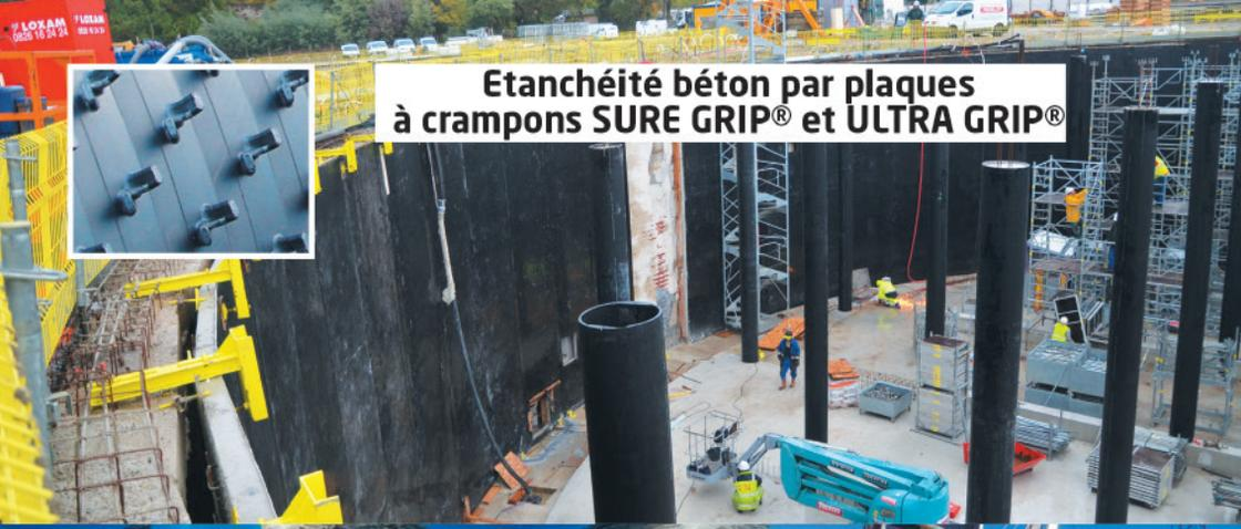
Etanchéité béton par plaques à crampons SURE GRIP® et ULTRA GRIP®
