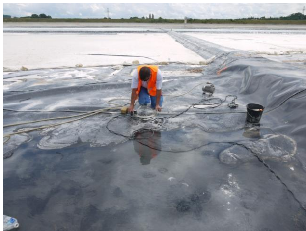
Crédit Photo YGD CONSEIL – Recherche de fuites à la cloche à vide
