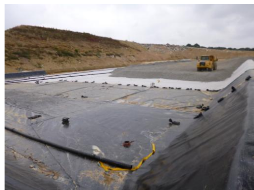
Crédit photo Antea – site SITA - ISDnd – mise en place de cailloux drainants sur la géomembrane protégée par un géotextile
