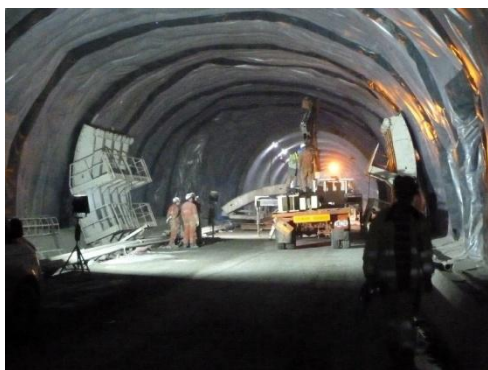
Crédit photo CEREMA - Dépose d'éléments de l'outil coffrant de l'anneau de revêtement béton sans protection du DEG
