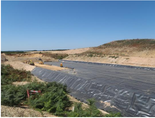
Crédit photo Antea – site SITA - ISD non dangereux - Contrôle extérieur de pose de la barrière Active comportant une géomembrane PEHD (Polyéthylène Haute densité) de 2mm
