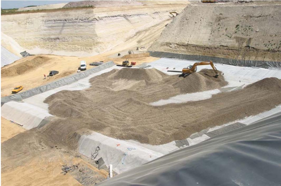
Figure 1. CSDU d'Attainville (95), vue du dispositif d'étanchéité-drainage en fond
