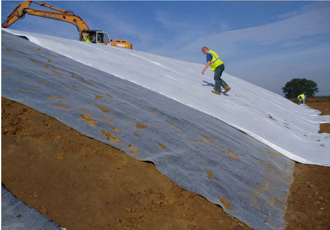
Photographie 2. En talus : limon, GSB et géocomposite de drainage (SITA Nord – SCETAUROUTE)
