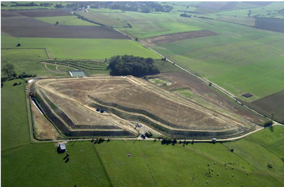
Photographie 6. Vue aérienne en fin de chantier (SITA Nord – SCETAUROUTE)
