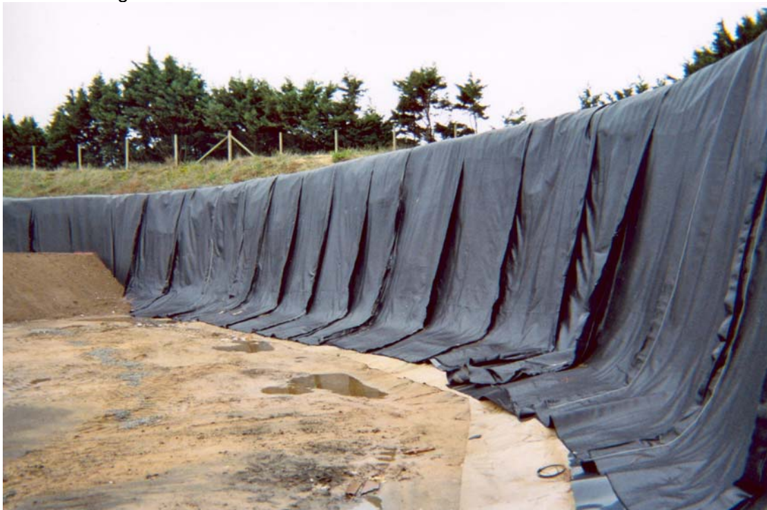
Figure 3. Lés mis en œuvre sur les flancs
