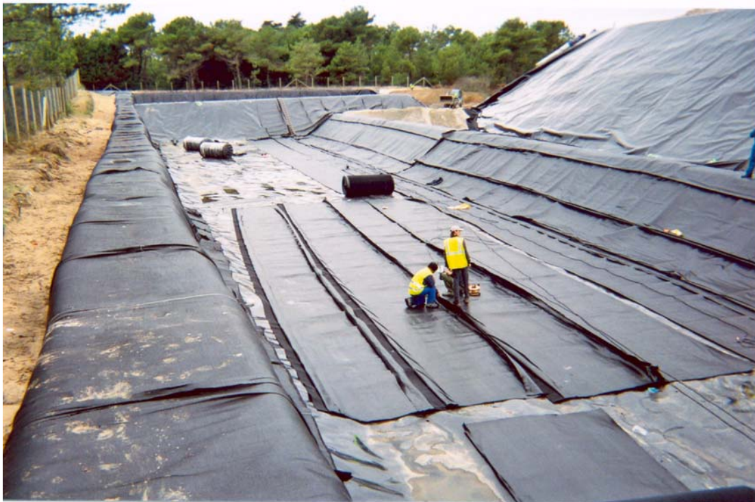
Figure 1. Pose de la nappe drainante lixiviats sur l'étanchéité
