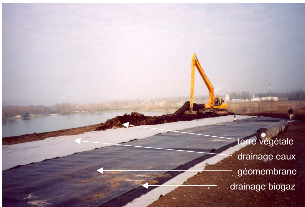
Figure 6. Mise en œuvre de la couverture : des bandes de drainage biogaz à la terre végétale
