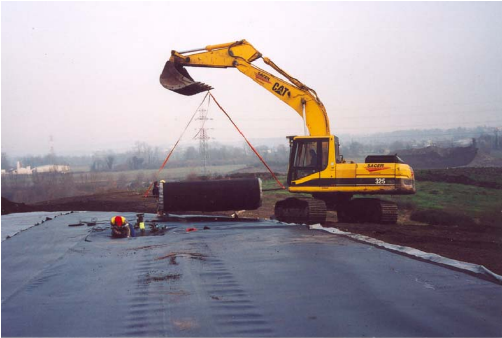
Figure 5. Mise en œuvre de la nappe drainante directement sur la géomembrane PEHD
