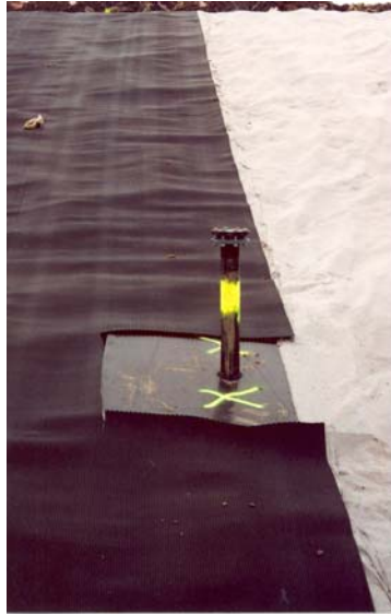
Figure 3. Connexion du réseau de collecte des biogaz à une bande de dégazage
