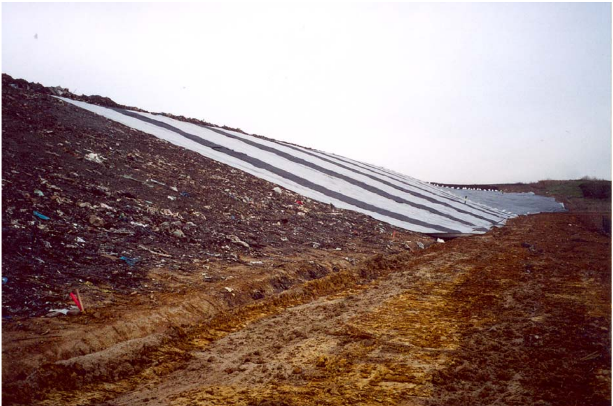
Figure 2. Bandes de drainage de biogaz sur le massif de déchets
