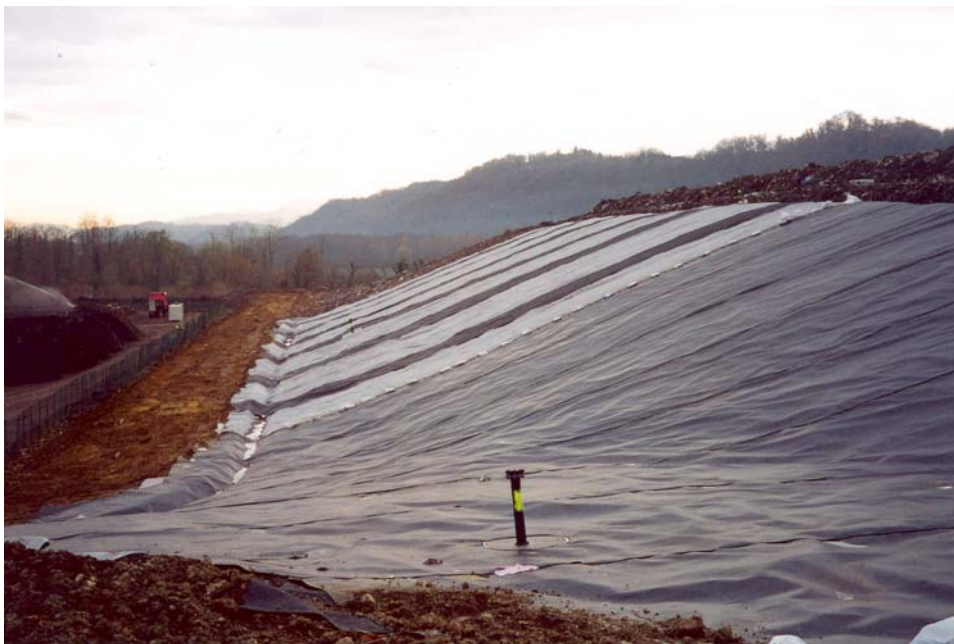
Figure 4. Mise en œuvre de l'étanchéité sur géotextile de protection / bandes de drainage
