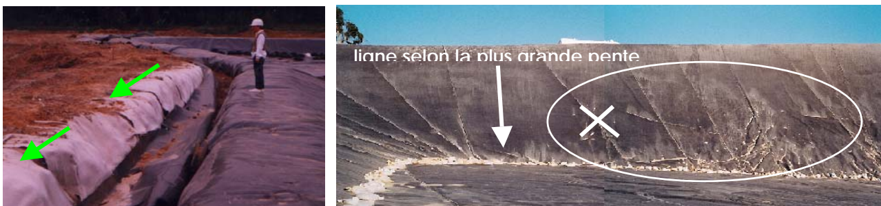
Figure 14. Anomalies dues au mauvais positionnement des géosynthétiques.
