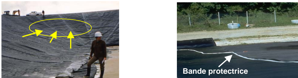
(a) soudures de géomembranes texturées (b) soudures avec la bande protectrice
