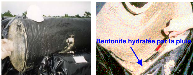
Figure 8. Endommagement d'un géocomposite bentonitique (Lopes, 2002b).
