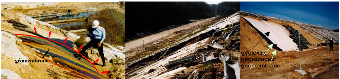
Figure 3. Exemples de glissements des couvertures sur les talus.
