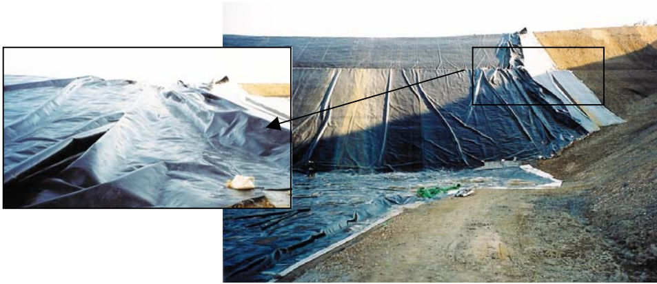
Figure 12. Anomalies dues au vent et l'insuffisance de lestage.
