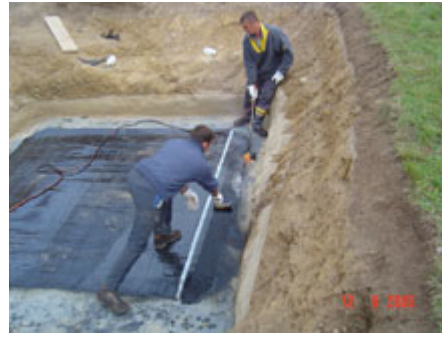
Photo n° 5 - Mise en place d'une membrane neuve
