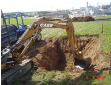
Photo n° 2 - Creusement de la couverture pour atteindre la membrane
