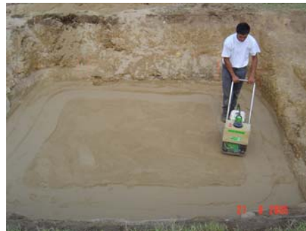
Photo n° 7 – Mise en place du sable sur la géomembrane
