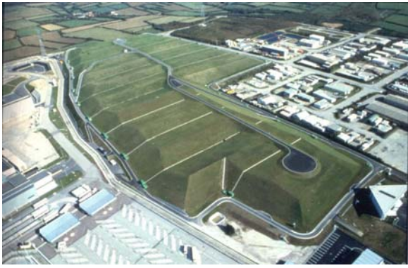
Photo n° 1 - Vue aérienne du Centre de la Manche
