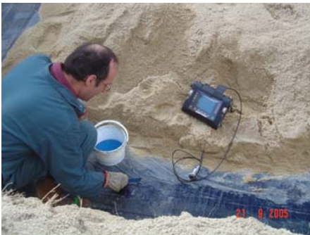
Photo n° 6 – Contrôle par ultrasons des soudures de géomembrane
