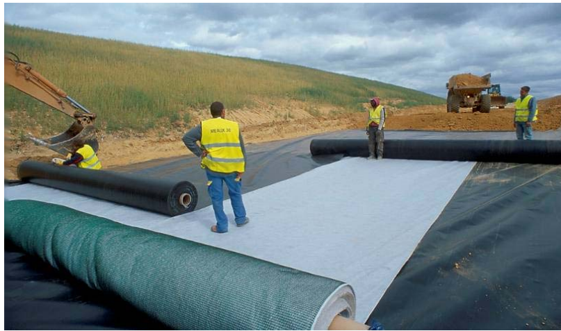
Figure 10. Mise en place du géotextile de renforcement. Noter la mise en œuvre des deux nappes de géofilm pour la protection vis-à-vis des agressions chimiques.
