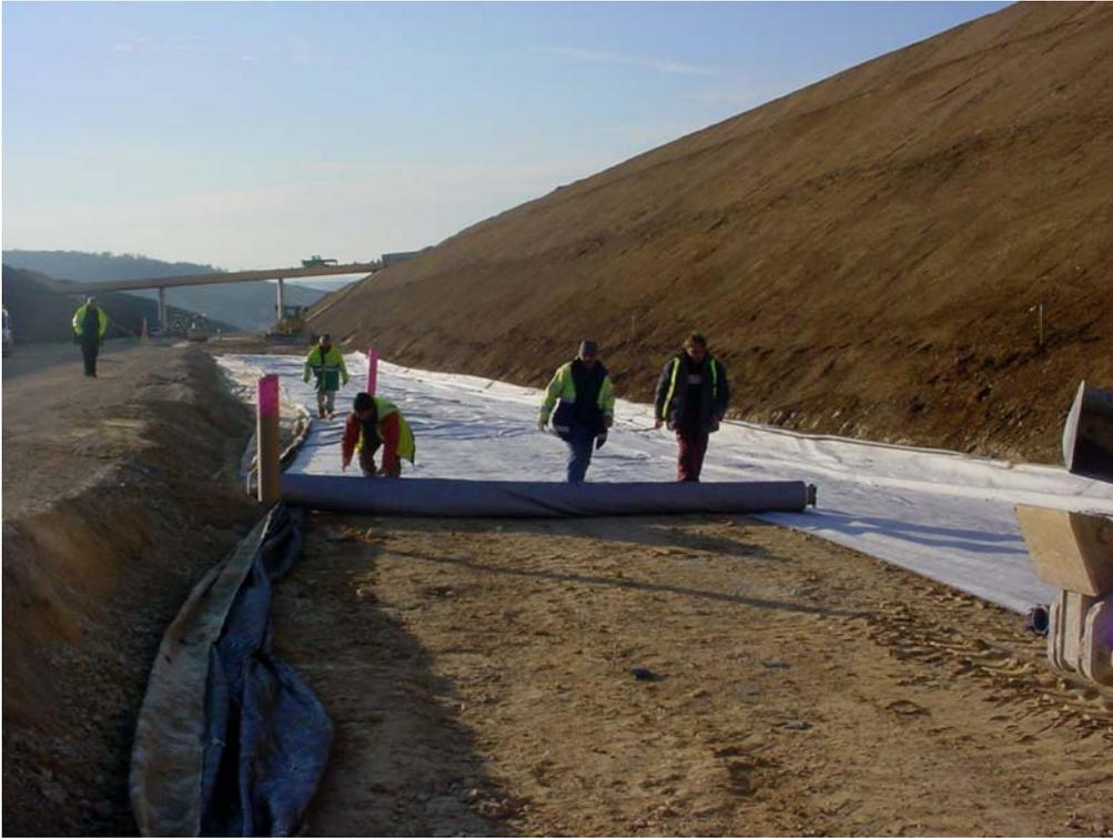
Figure 1. LGV EST Tronçon E lot 32 – Renforcement par géosynthétique
