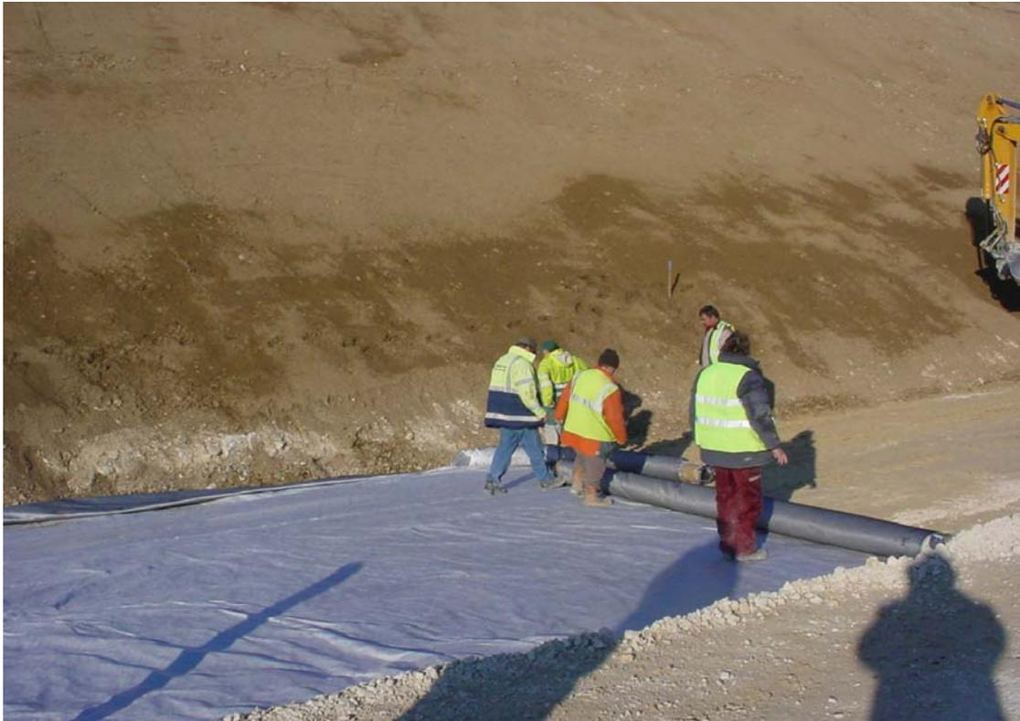
Figure 7. Déroulement du géosynthétique
