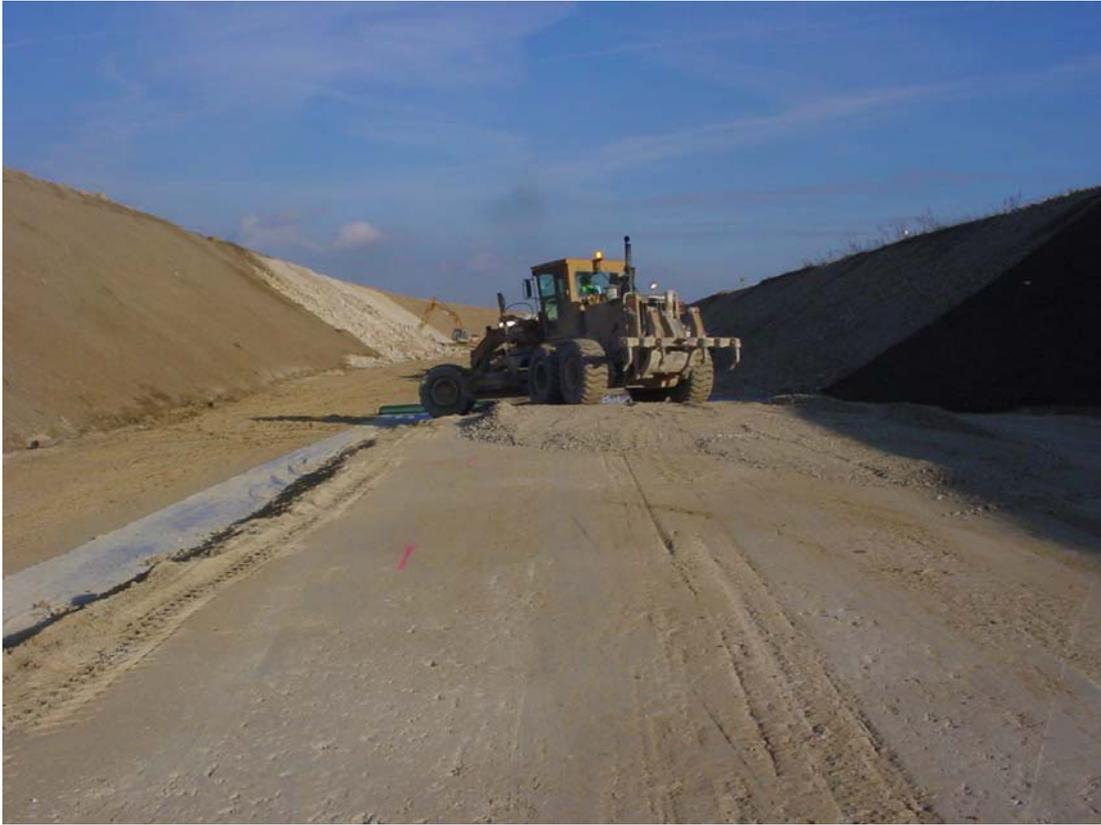
Figure 8. Mise en œuvre de la PST sur le géosynthétique
