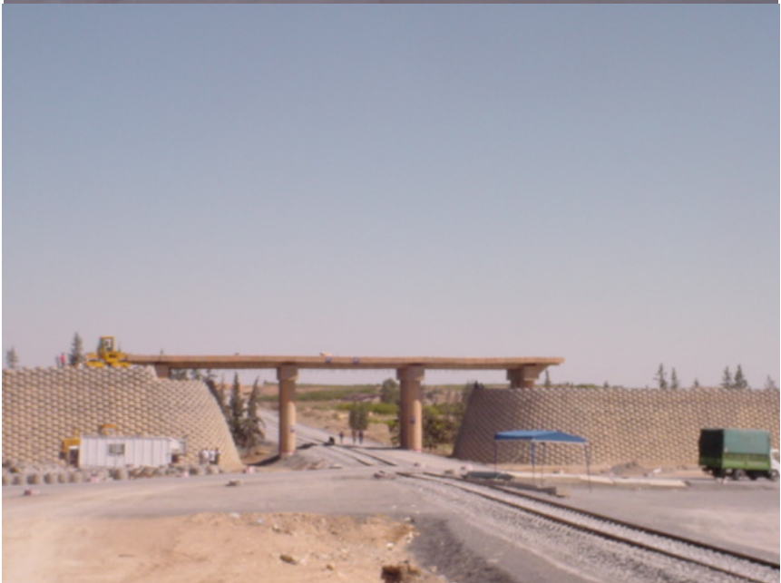
Figure 14. Vue de l'ouvrage en construction
