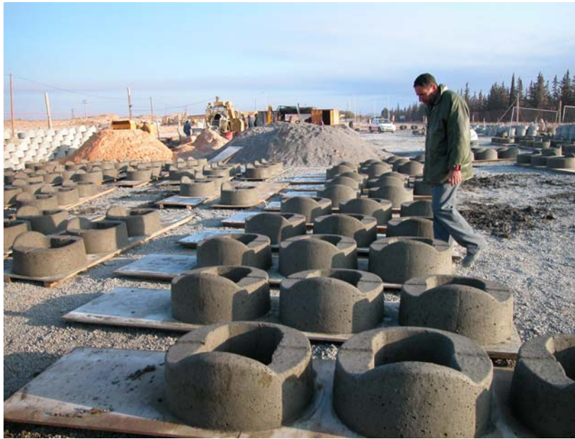
Figure 7. Zone de séchage des éléments cellulaires du parement
