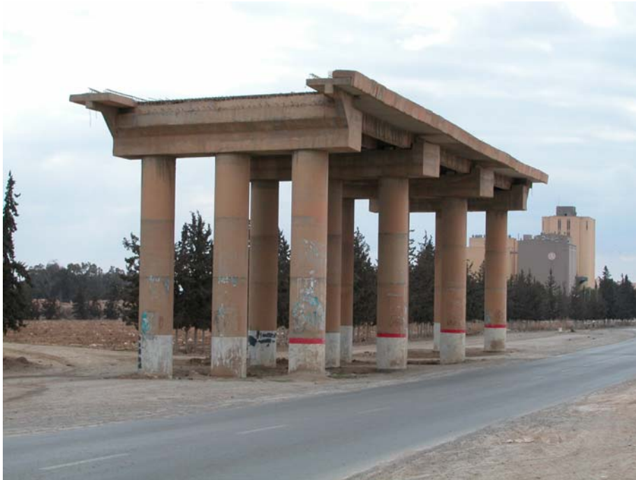
Figure 2. Vue de l'ouvrage, de l'exploitation agricole et des habitations
