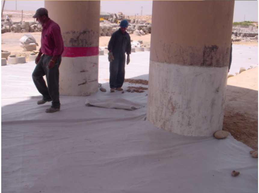
Figure 13. Détail de la pose des géotextiles au droit des piles
