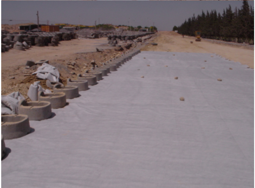
Figure 11. Pose des éléments de parement et des nappes géotextile de renforcement
