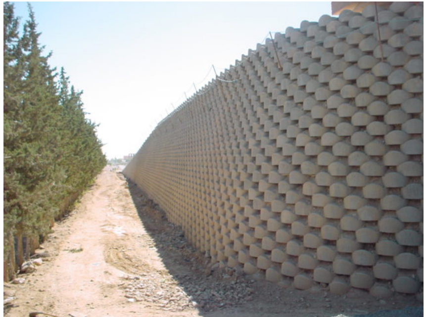
Figure 15. Vue du talus raidi et de la rangée d'arbres à préserver
