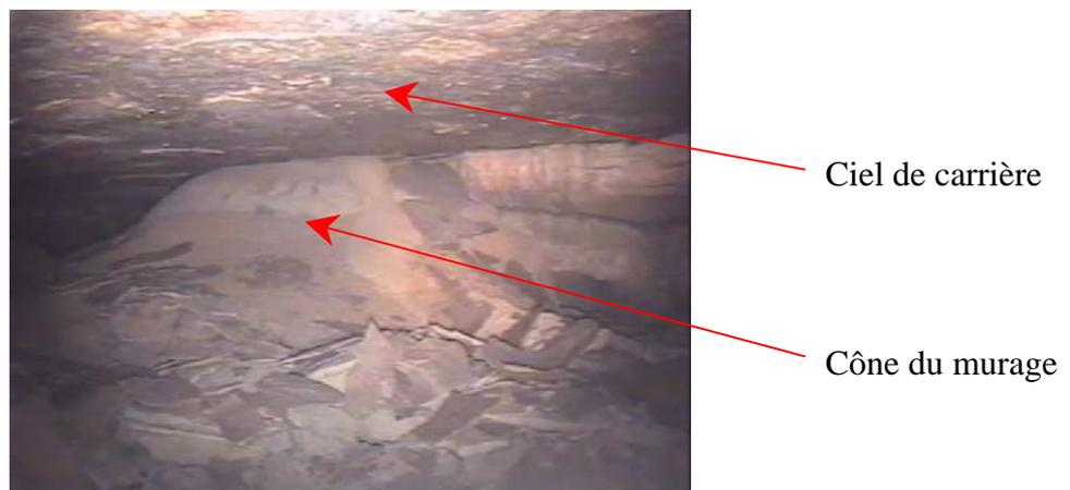
Figure 8. Contrôle par vidéo-scopie du murage délimitant la zone d'ancrage de la géogrille.
