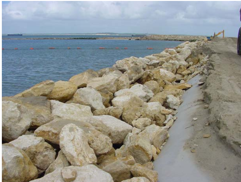
Figure 8 : Pose des enrochements sur le tube supérieur de la digue de fermeture
