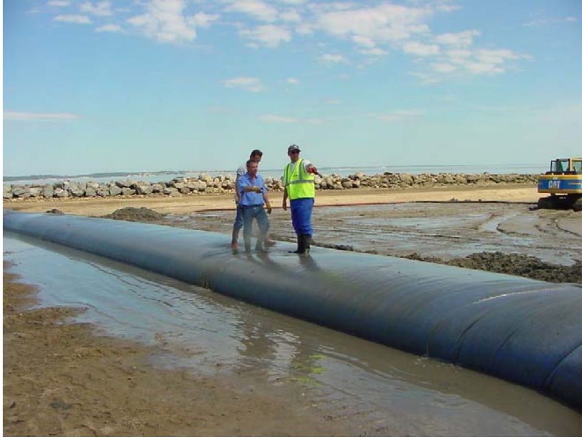
Figure 6. Tube en cours de remplissage
