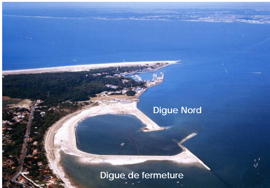
Figure 3. Vue aérienne du chantier
