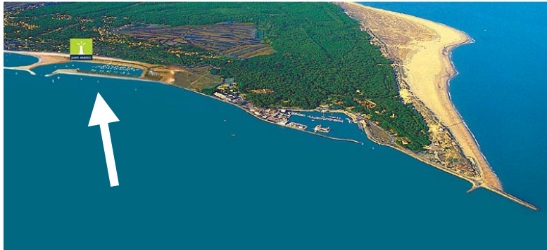
Figure 1 Emplacement de Port Médoc sur l'estuaire de la Gironde à la pointe du Médoc.
