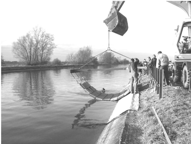
Figure 5. Mise en place d'un élément de pavés béton
