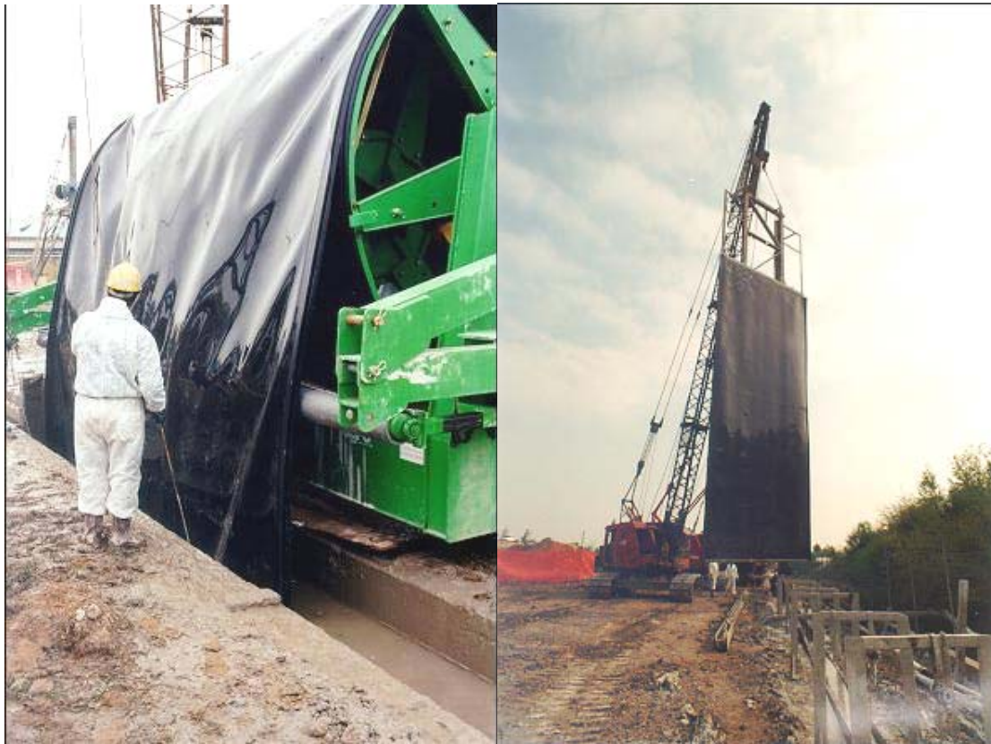
Figure 8. Deux dispositifs de mise en œuvre de géomembrane PEHD en parois : enroulement et palfeuilles ; avec l'accord d'Agro France
