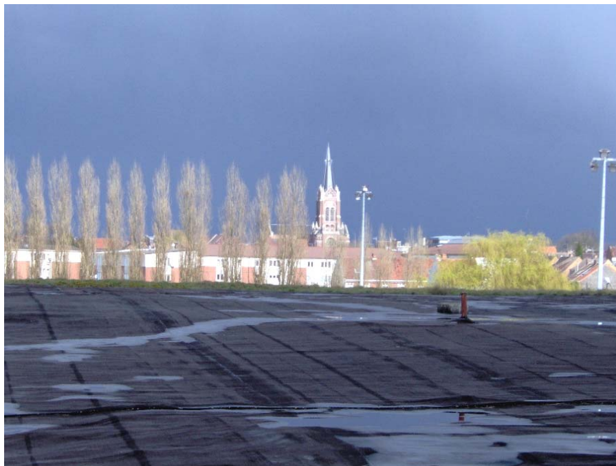
Figure 12. Couverture du « Grand Terril des charrées de chrome » de Wattrelos, en 2008, 22 ans après la pose de la géomembrane bitumineuse
