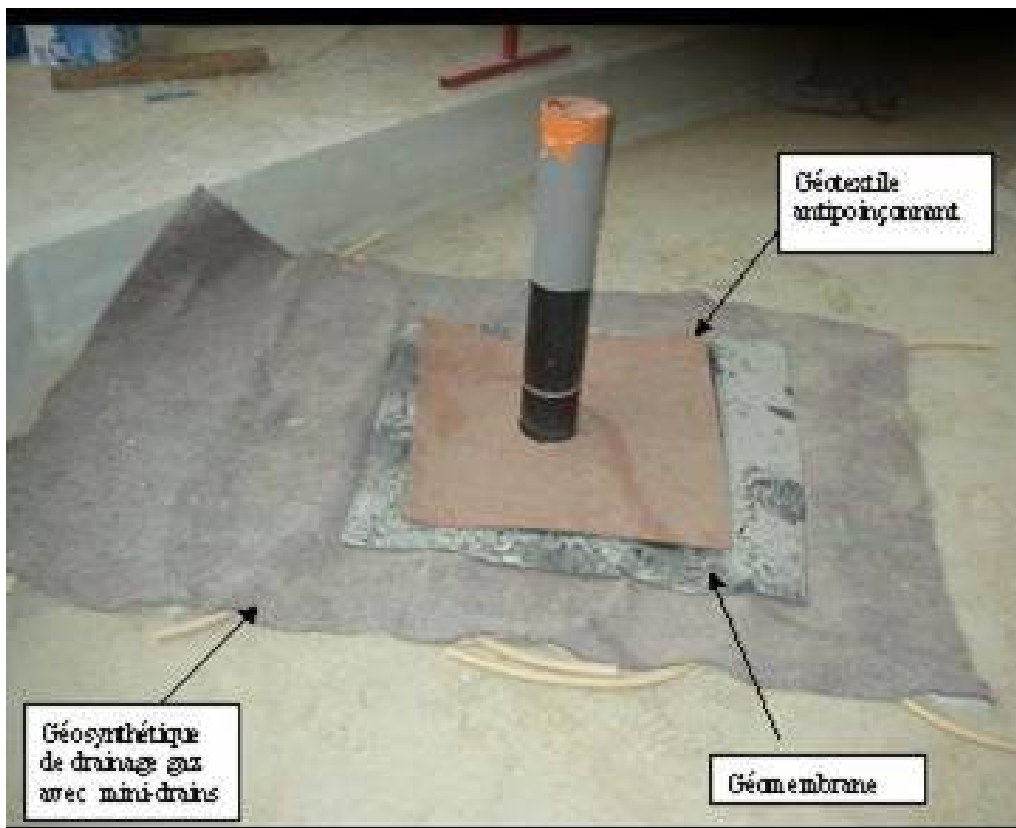
Figure 11. Transformation d'un bâtiment en Centre de conférences (2003) ; Produits géosynthétiques mis en œuvre sous la dalle, avec détail de raccordement sur tube PVC (in Ouvry et Pecci, 2006)
