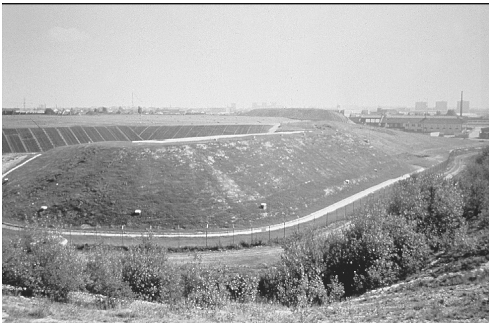
Figure 4. Le « Grand terroir de Cr VI » de Wattrelos : au premier plan, son annexe, rapportée en 1998, est un confinement « hors site » par géomembrane bitumineuse (Ballie et al., 1999)
