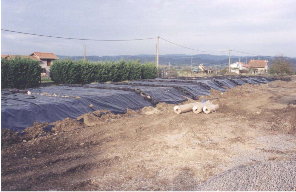
Figure 6. Couverture d'un biotierre exposé aux intempéries : géofilm en polyéthylène
