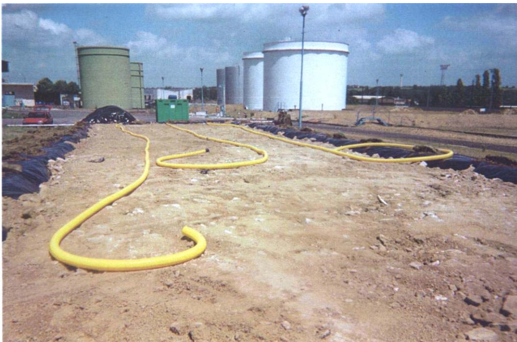
Figure 7. Mise en place de drains d'aspiration dans un biotierre
