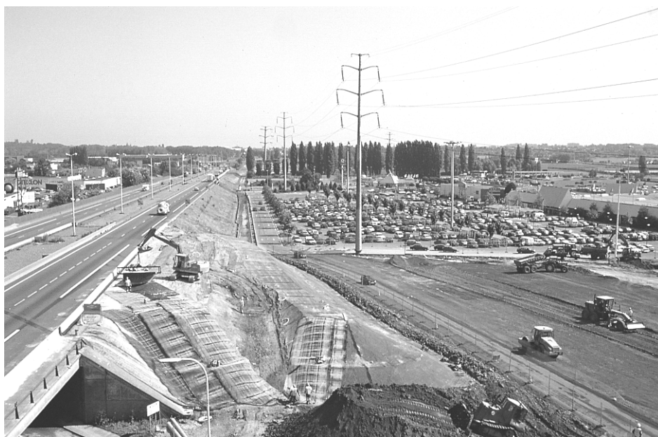
Figure 2. Confinement sur site, par géomembrane bitumineuse, des charrées de Cr VI excavées sous un parking Auchan en 1998 (Duwelz et al., 1999)
