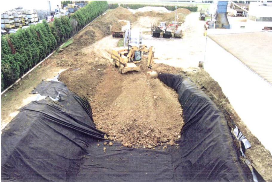
Figure 1. poinçonnement possible lors du remplissage d'un confinement «sur site »
