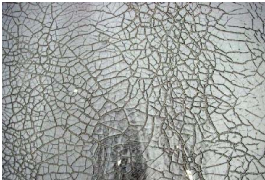
Figure 13. Détail des craquelures dues au vieillissement de la géomembrane bitumineuse exposée aux intempéries sur le terril de Wattrelos, en 2008.
