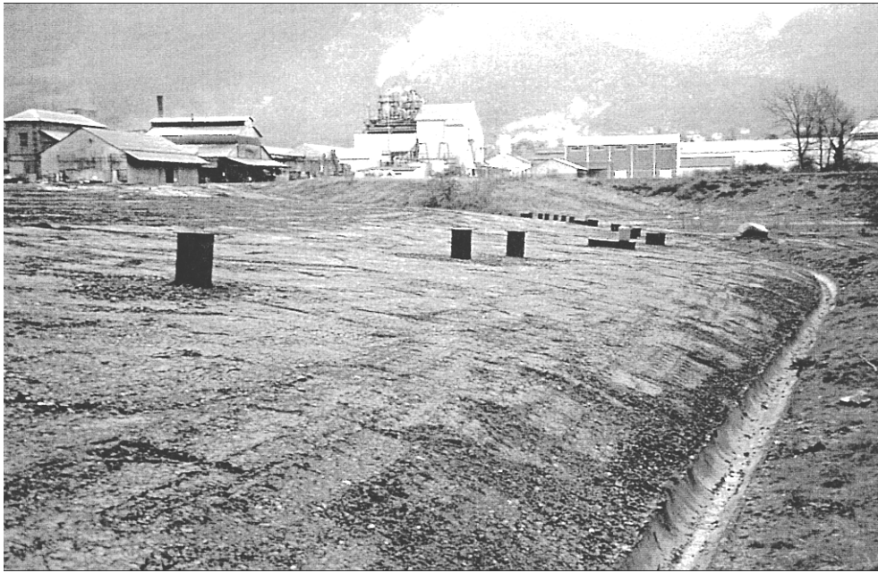
Figure 3. « Tombeau d'arsenic » étanché par géomembrane PEHD en 1997 (De Bont et Ouvry, 1999)
