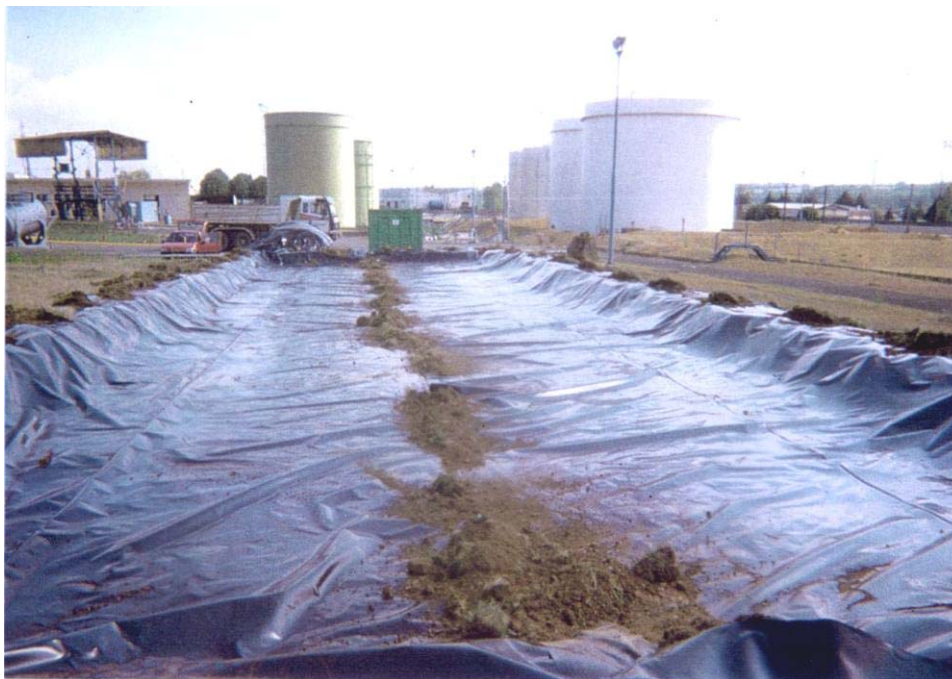
Figure 5. Dispositif basal d'un biotertre comportant un géofilm en polyéthylène
