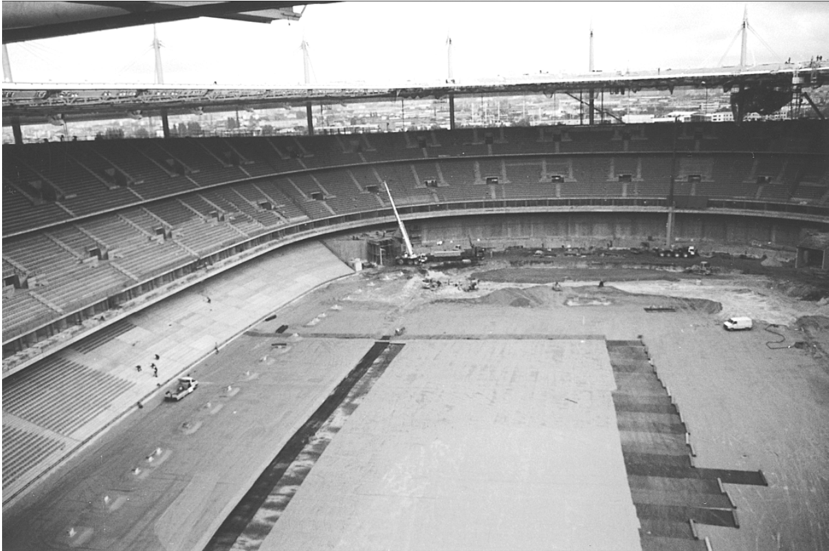
Figure 10. Mise en œuvre d'un dispositif avec géomembrane PVC pour améliorer la récupération des polluants sous les pelouses du Stade de France en1996 (Bourassin et al., 1999)
