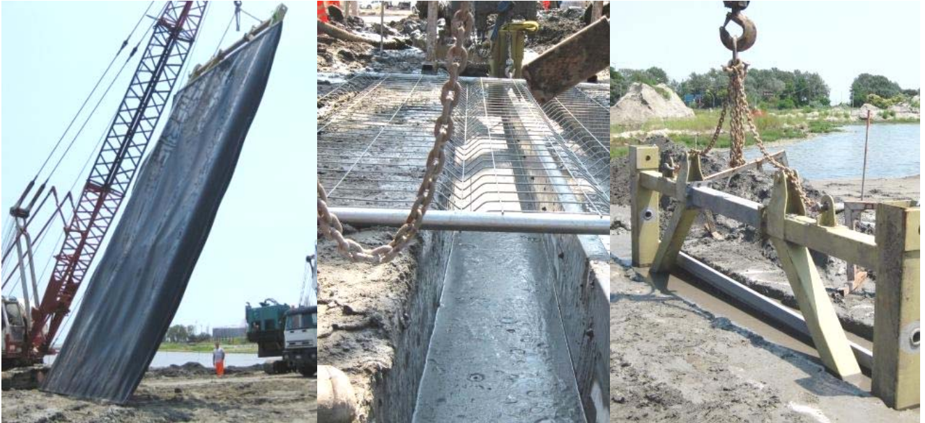
Figure 9. Différentes étapes de la mise en œuvre d'une palfeuille PEHD dans une tranchée au coulis bentonite/ciment ; avec l'accord d'Agro France
