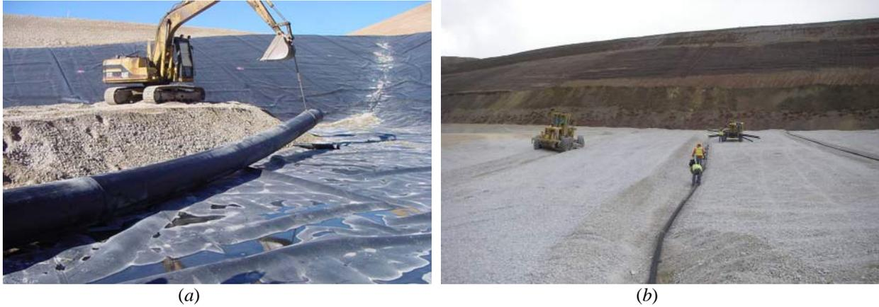
Figure 8. Installation de tubes rigides en PE : (a) sans tranchée et (b) installation dans une tranchée
