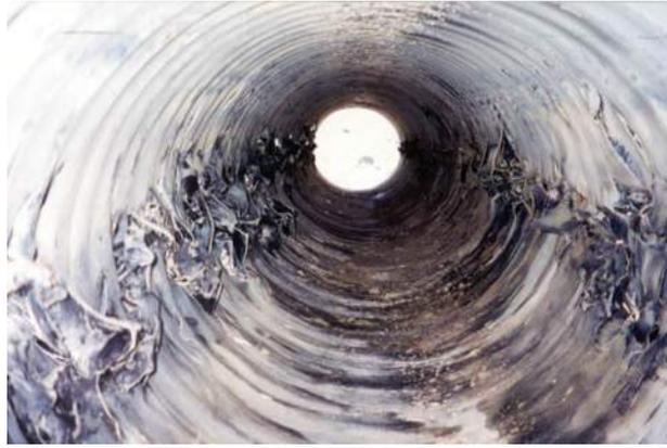
Figure 13. Rupture de géodrain
