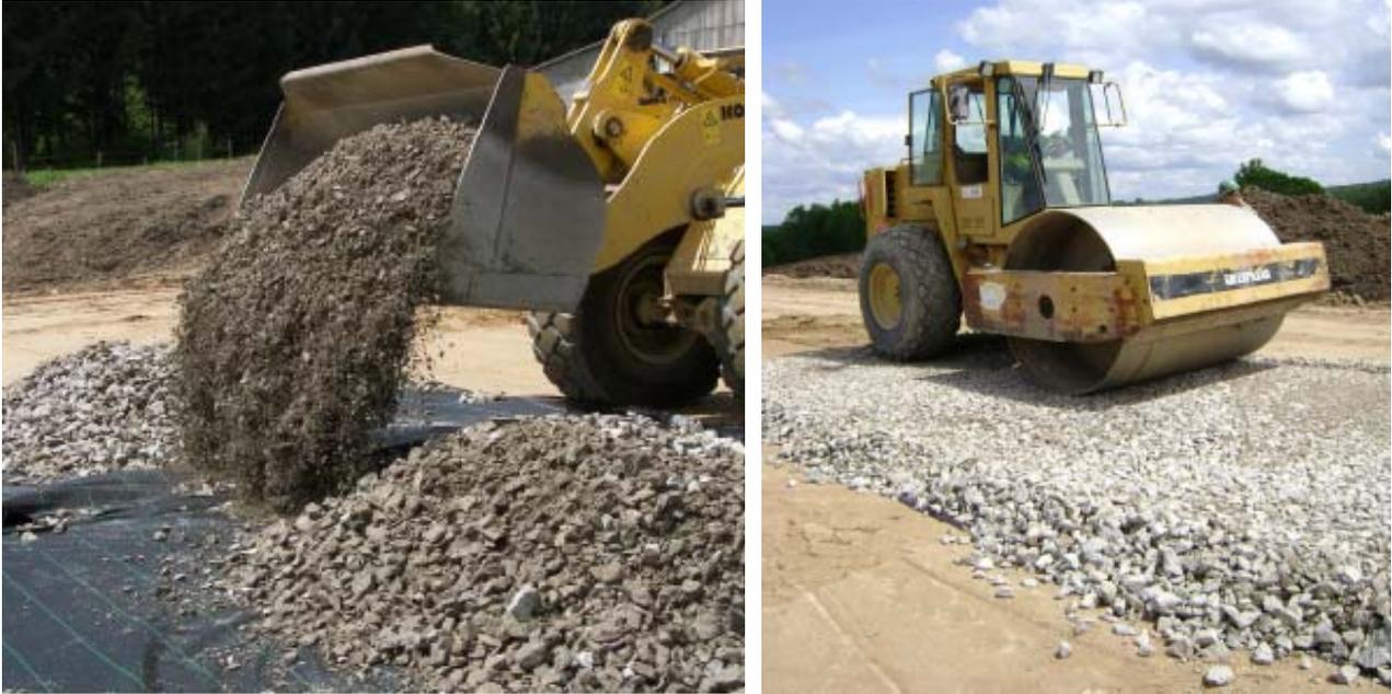
Figure 1. Mise en place du matériau d'apport et compactage au rouleau vibrant
