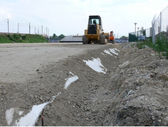
a) Mise en œuvre des lés transversaux
