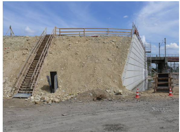
d) Montage du remblai
