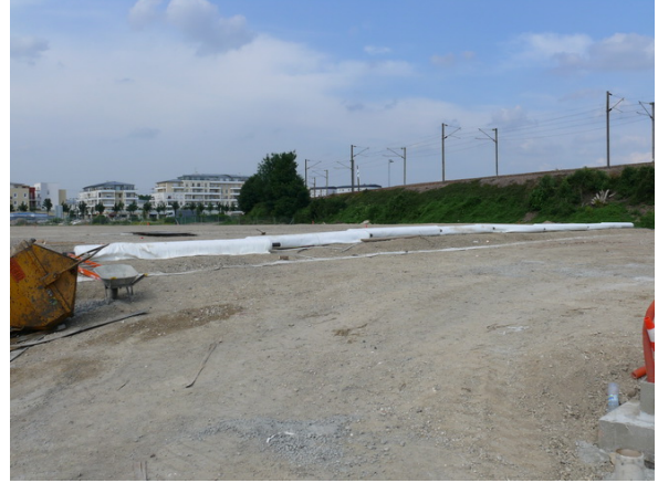
b) Mise en œuvre des lés longitudinaux
