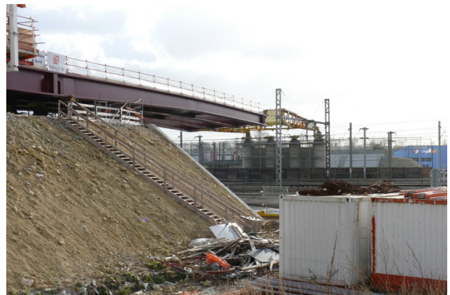
f) Lancement du tablier au dessus des 8 voies ferroviaires
