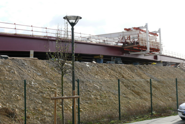
e) Préparation du tablier sur le remblai
