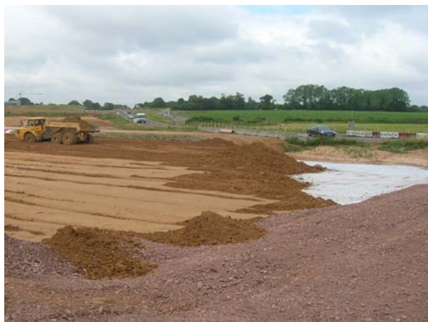
Figure 6. Cas n°1 - mise en œuvre de la couche de forme traitée sur les nappes de géosynthétique
