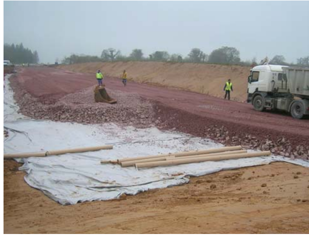
Figure 7. Cas n°2 - mise en œuvre des matériaux granulaires non traités sur la nappe de géosynthétique
