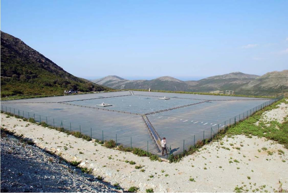
Figure 10. Réservoir souple d'Ersa 15000 m<sup>3</sup>, plein. On observe les gorges de mise en tension, (remplies d'eau), les 2 trappes de visite et les 6 événements
