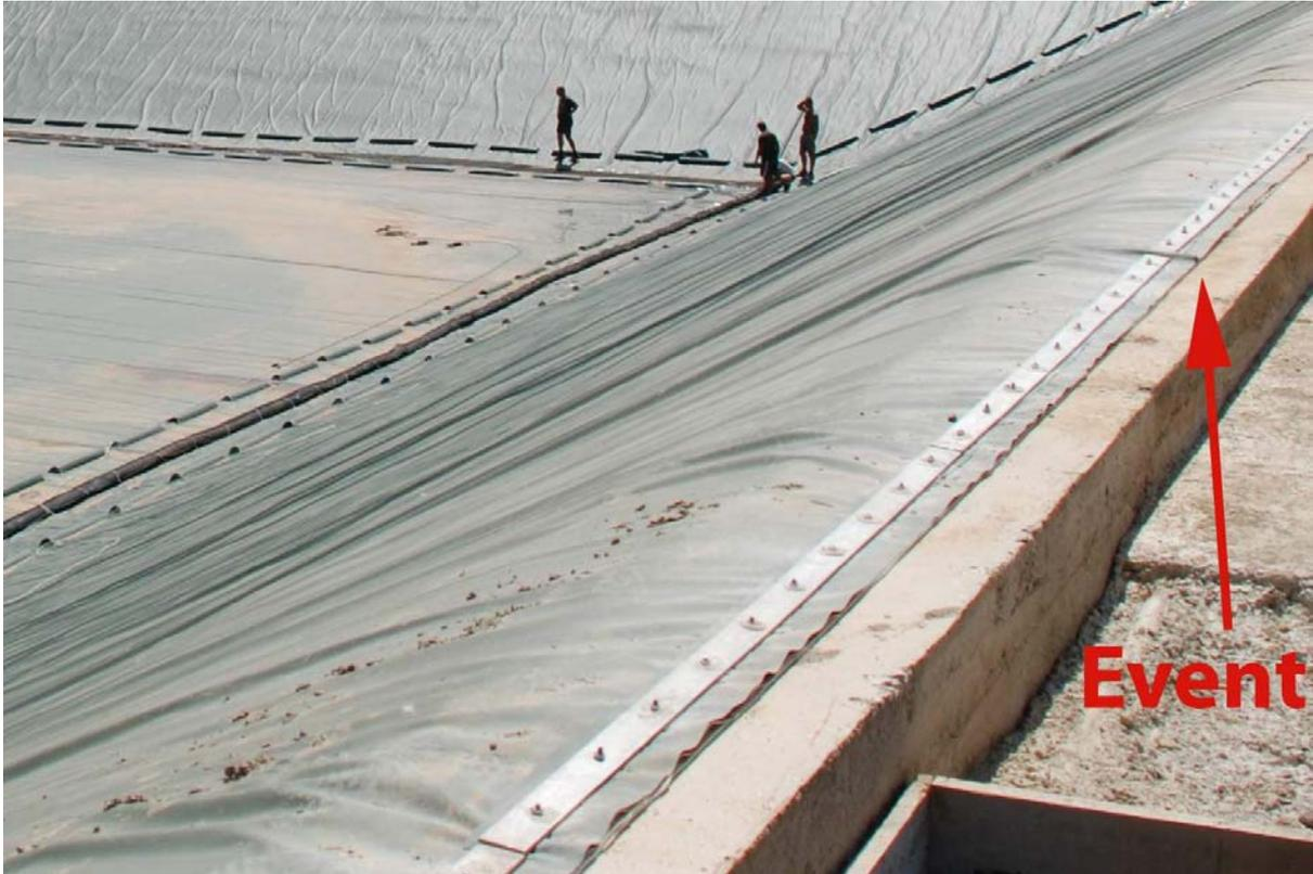
Figure 6. Bassins de Cargèse. Détail de l'ancrage en tête sur longrine béton, et évent dans l'ancrage. En pied de talus, on voit les lignes de flotteurs et la ligne de lest qui forment le dispositif de mise en tension
