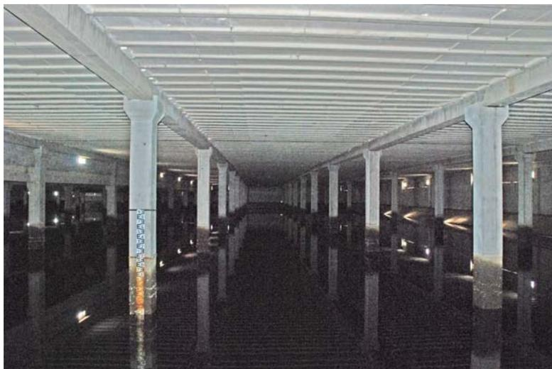
Figure 2. Intérieur du réservoir de Salvi: forêt de poteaux supportant les 8300 m<sup>2</sup> de couverture en béton
