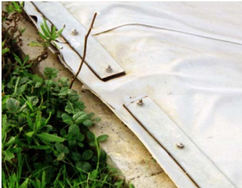
Figure 7. Détail de l'évent dans l'ancrage en tête sur longrine en béton (bassin de Rogliano).
