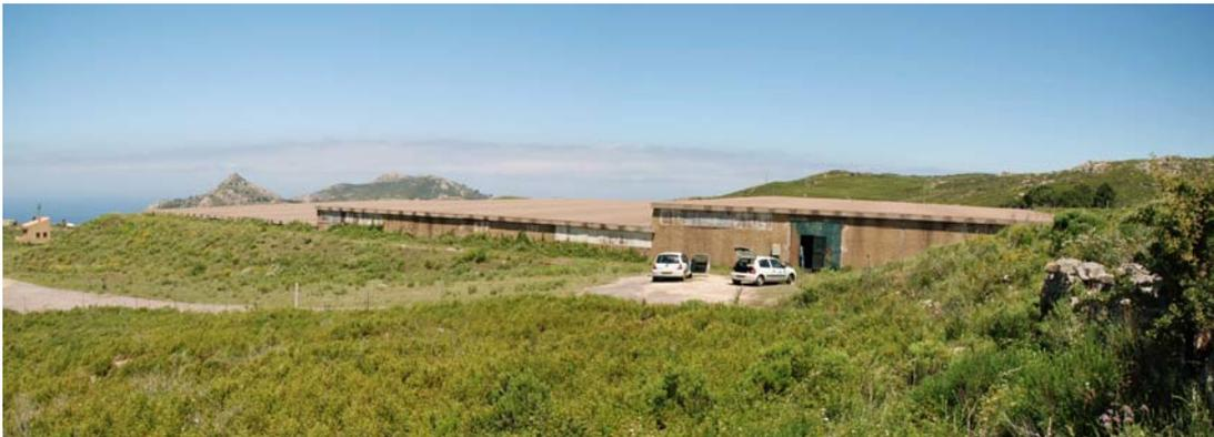
Figure 1. Vue d'ensemble du réservoir de Salvi : couverture en béton sur stockeage en géomembrane. Le réservoir est carré (91 x 91 m); la toiture comprend 3 niveaux pour améliorer l'intégration au paysage.
