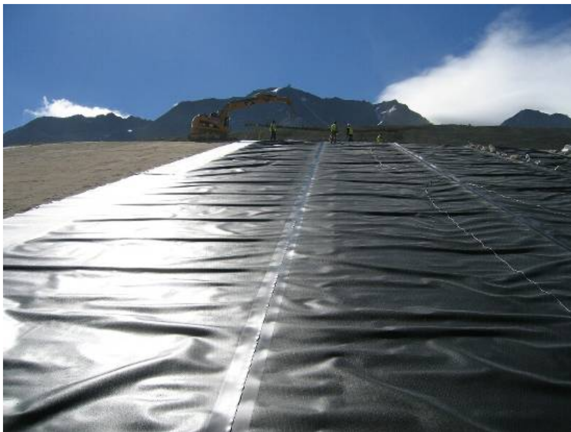
Figure 8. Plis dans la membrane VLDPE exposée au soleil
