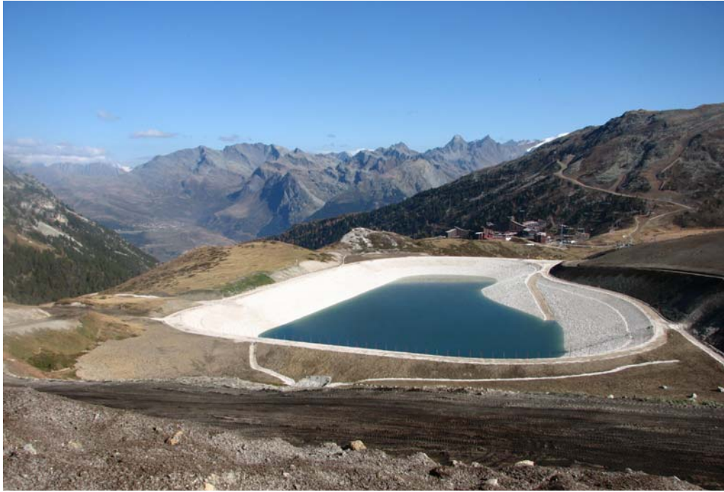
Figure 11- La retenue de l'Adret des Tuffes à la fin de la mise en eau partielle le 25/10/2008
