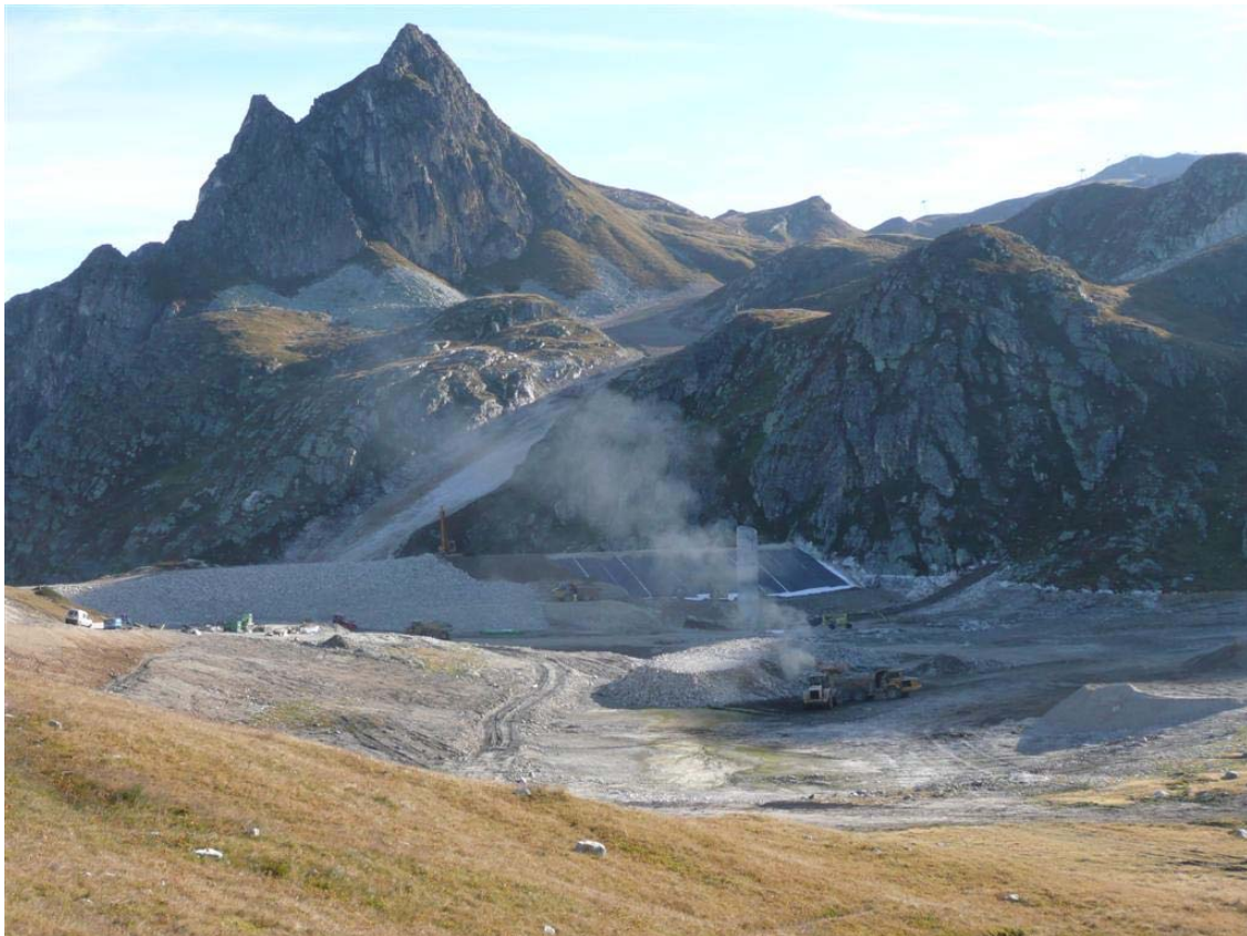
Figure 1. Situation du barrage des Blanchets
