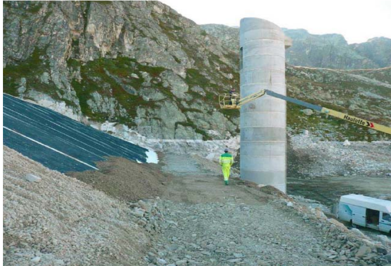
Figure 14. Mise en œuvre de la protection
