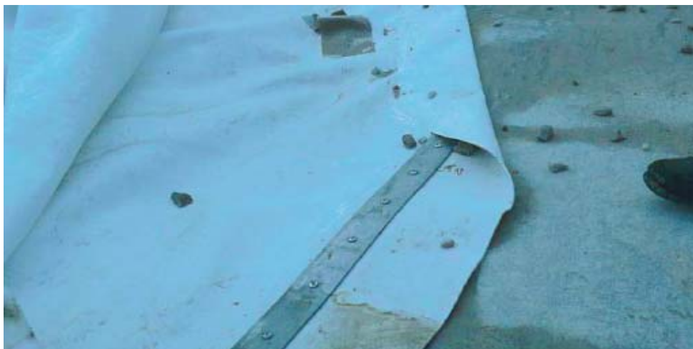
Figure 15. Raccordement à la plinthe
