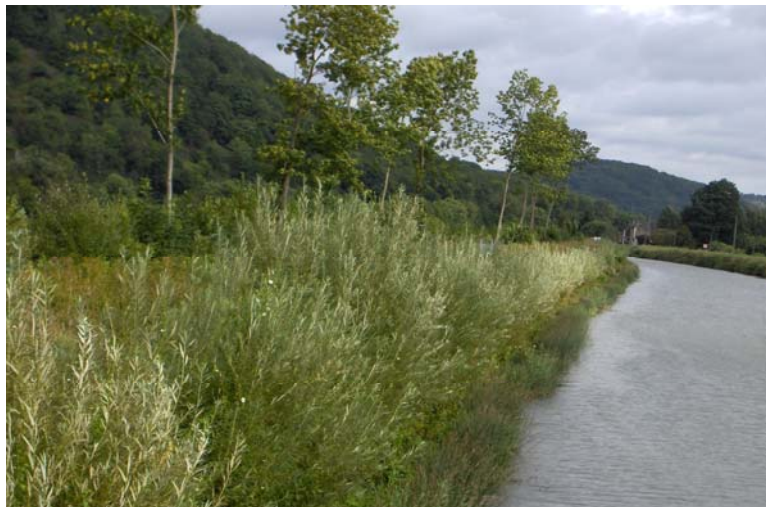
Figure 8. Vue de la digue de Montigny après aménagements en 2008 (source Cetmef)
