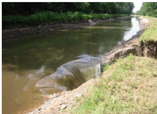
Figure 2. Vue de la brèche dans la digue à Briennon (source VNF)
