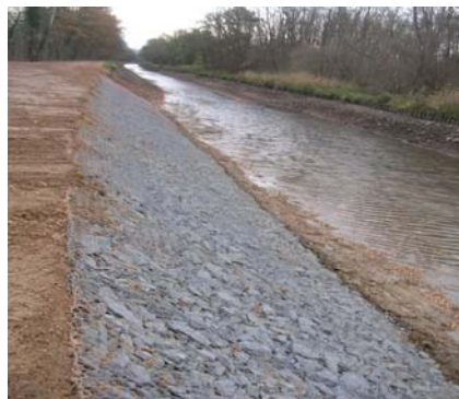
Figure 4. Vue des matelas de gabions après les travaux de réparation de la digue à Briennon (source VNF)
