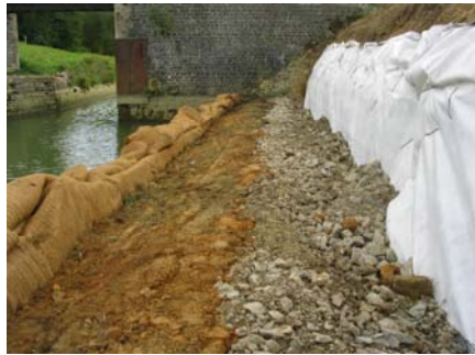
Figure 6. Vue des travaux. La nappe blanche correspond au géotextile de filtration et la nappe brune au géotextile coco (source VNF)
