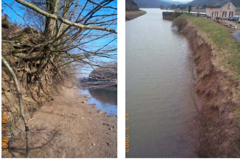
Figure 5. Vue des anses d'érosion de la digue de Montigny (source VNF)
