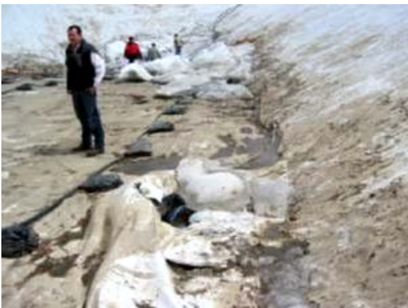
Figure 4. Chutes de blocs de glace ayant entraîné des déchirures décimétriques de la géomembrane en fond de retenue
