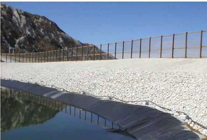
Figure 2. Exemple de risberme et de recouvrement partiel de la géomembrane en partie haute du talus
