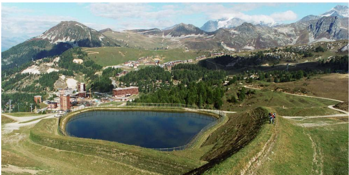
Figure 1. Exemple de retenue d'altitude
