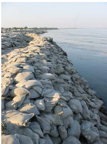
Figure 2. Protection des berges par conteneurs géosynthétiques (Photo: Oberhagemann)
