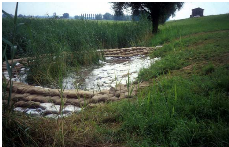
Figure 1. Barrières en sacs de sable (« Kaden »)
