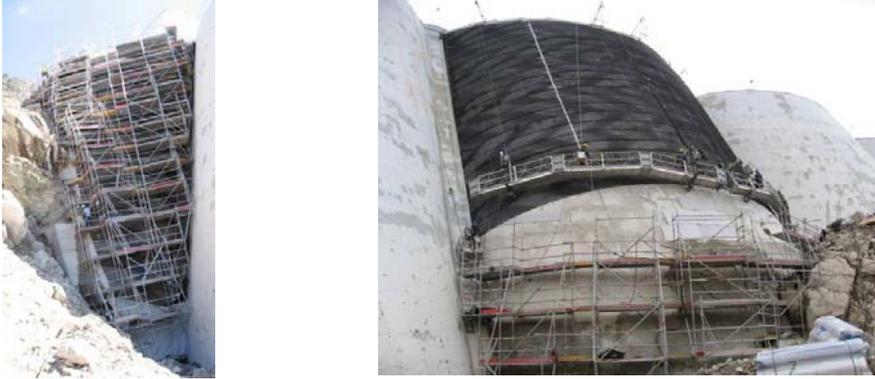
Figures 6 et 7. Échafaudages à la voûte 9, et installation du système d'étanchéité par nacelles volantes à la voûte 7 (dans la photo la mise en place du géodrain).
