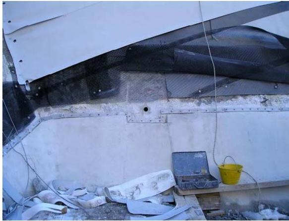
Figure 2. Géodrain et exutoire au-dessus de la fixation étanche à la voûte 7.
