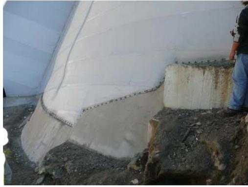
Figures 10 et 11. Les profilés de tensionnement étanchés par bandes de recouvrement, et fixation étanche en pied de voûte.
