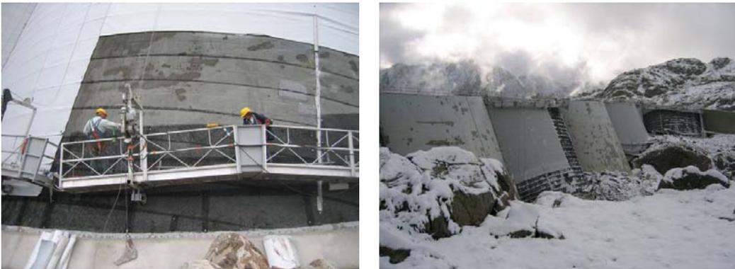
Figures 8 et 9. Installation du géocomposite et du deuxième profilé du système de tensionnement sur le géodrain. A droite, installation du géodrain sur la voûte 4 et du géocomposite sur la voûte 7. Une chute estivale de neige n'a pas compromis le maintien du délai contractuel.
