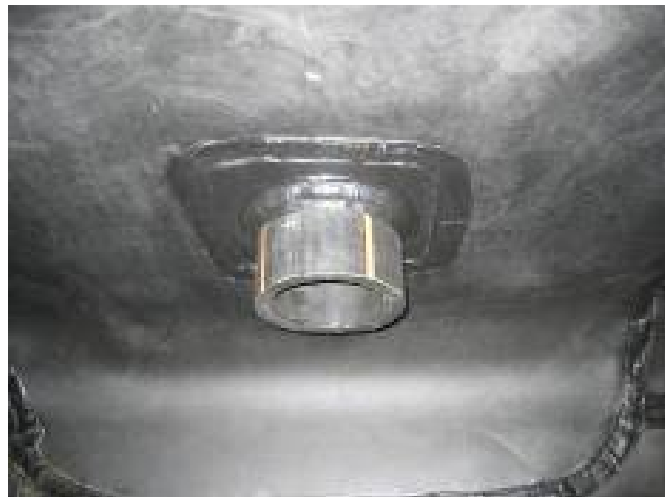
Figure 4. Raccordement sur canalisation
