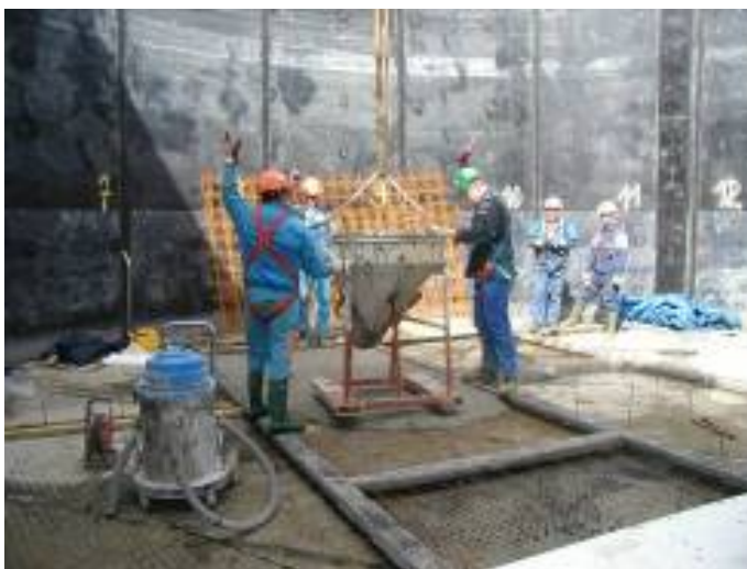
Figure 9. Coulage du béton entre les nus
