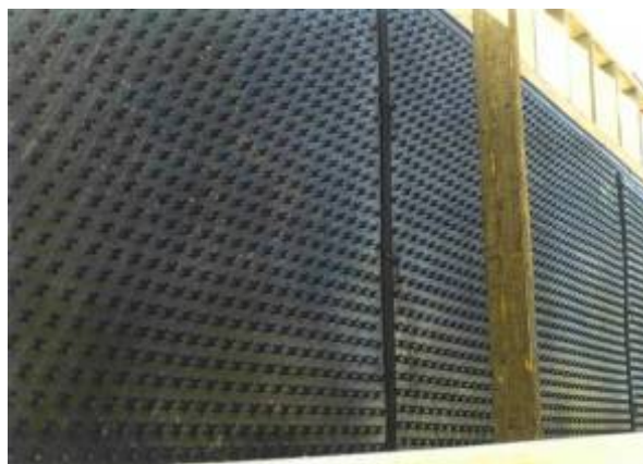
Figure 2. Mise en place de l'étanchéité sur les banches
