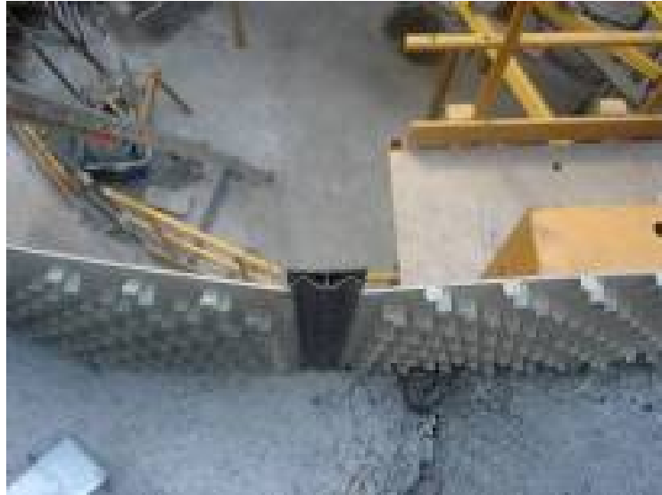
Figure 3. Détail du profilé « à déchirer »
