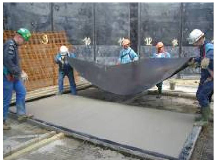
Figure 10. Mise en place de la plaque
