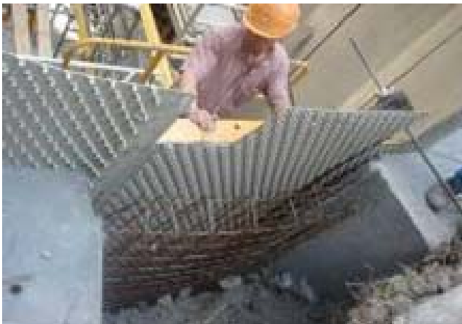
Figure 21. Réserve pour la pose d'une poutre
