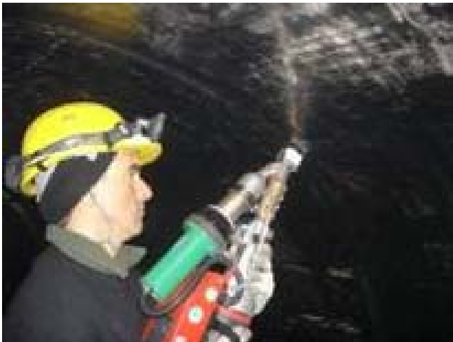
Figure 17. Soudure par extrusion
