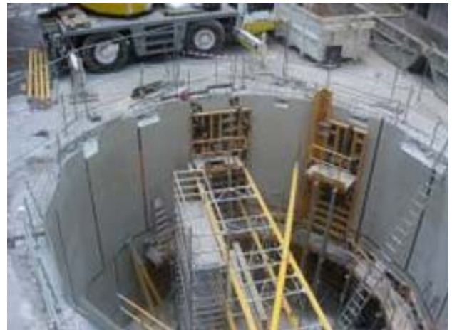
Figure 22. Vue d'ensemble de l'ouvrage avant le coulage du plancher
