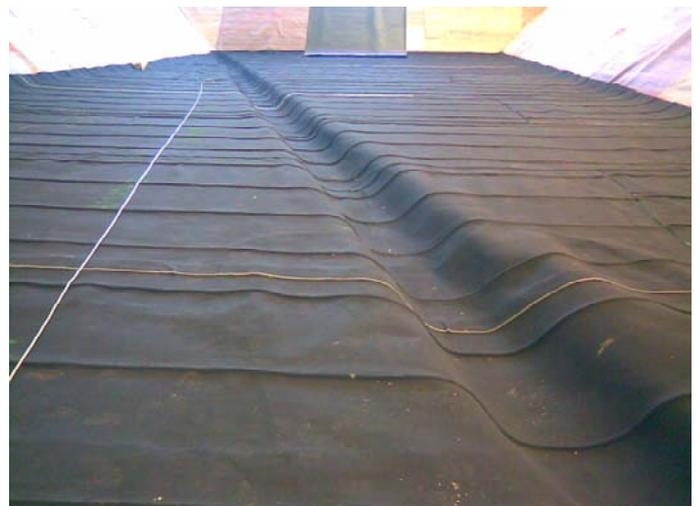
Figure 4. Protection et drainage de la géomembrane
