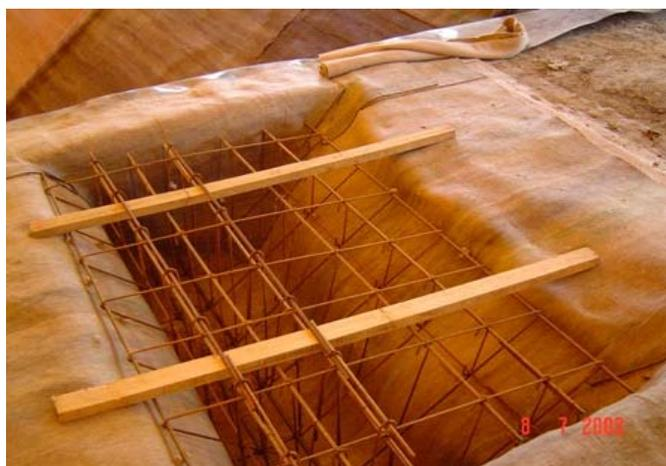
Figure 6. Bêche d'ancrage de la rampe
