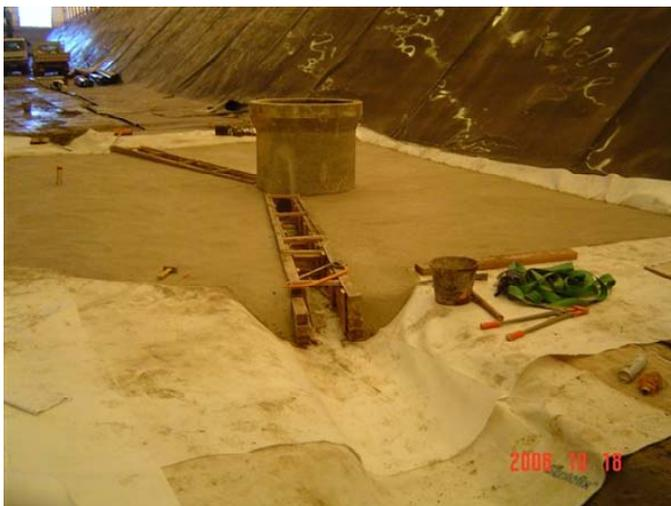
Figure 3. Puits de drainage de l'alvéole
