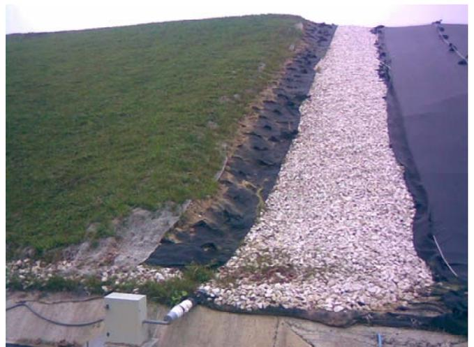
Figures 12 et 13. Système de protection, drainage et accroche de la terre
