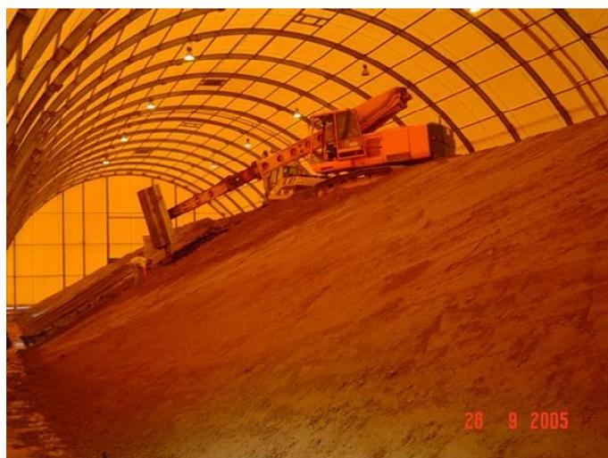
Figure 7. Couche support du DEG sur l'alvéole remplie
