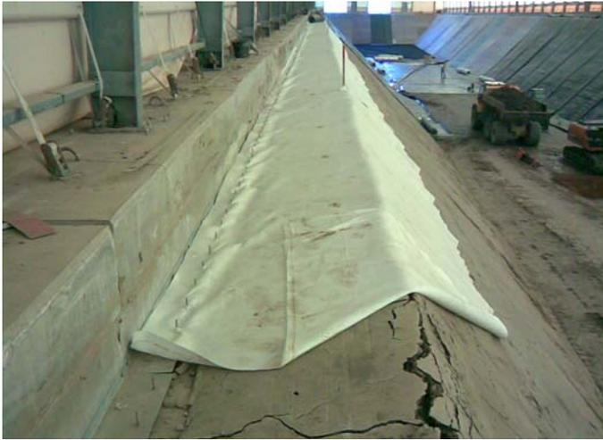
Figure 1. Ancrage des géosynthétiques
