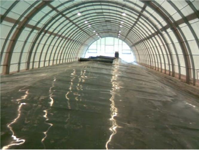
Figure 8. Géomembrane de fermeture
