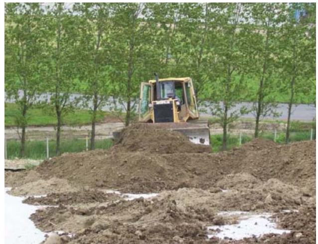
Figure 7. Remblai de la terre végétale
