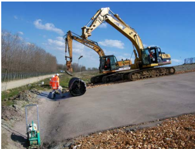
Figure 6. Pose du géocomposite drainant sur le complexe de bentonite-polymère
