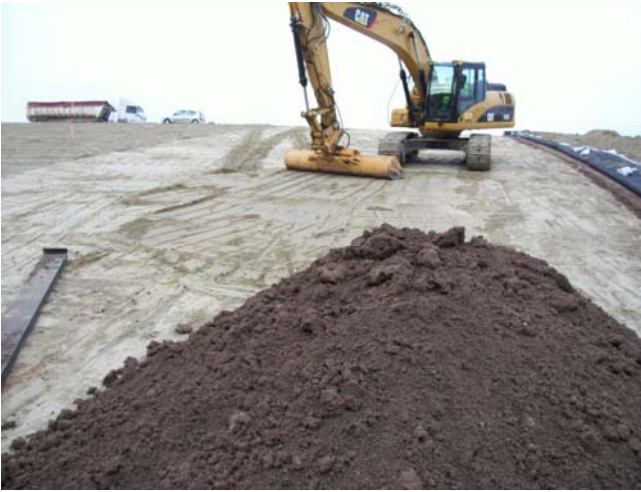
Figure 8. Réglage de la couche de forme à la pelle mécanique
