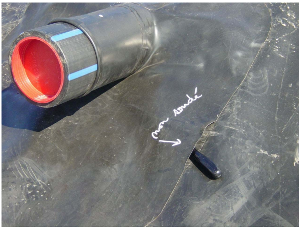
Figure 6. Mauvais raccordement aux ouvrages Figure 7. Ancrage insuffisant de la géomembrane
