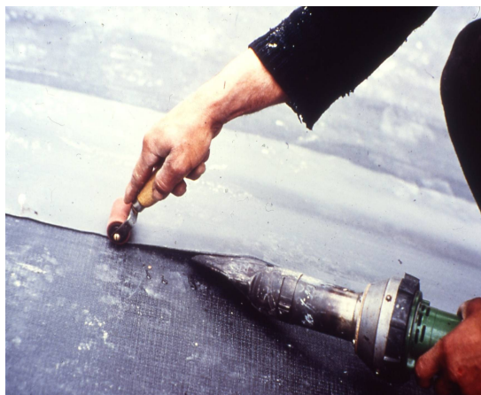
Figure 8. Géomembrane opaque soudée à la main – simple soudure
