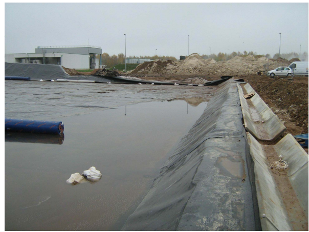
Figure 6. Mauvais raccordement aux ouvrages Figure 7. Ancrage insuffisant de la géomembrane
