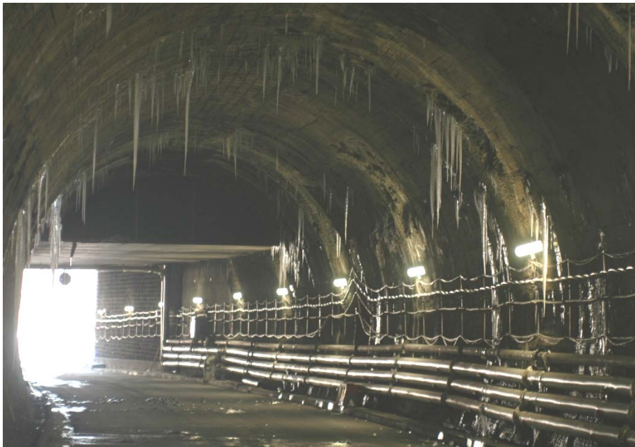
Figure 1. Conséquence de désordres d'étanchéité en cas de gel.
