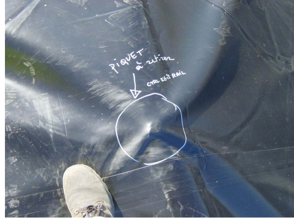
Figure 13. Préparation insuffisante du support
