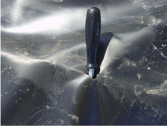
Figure 12. Mauvaise soudure manuelle
