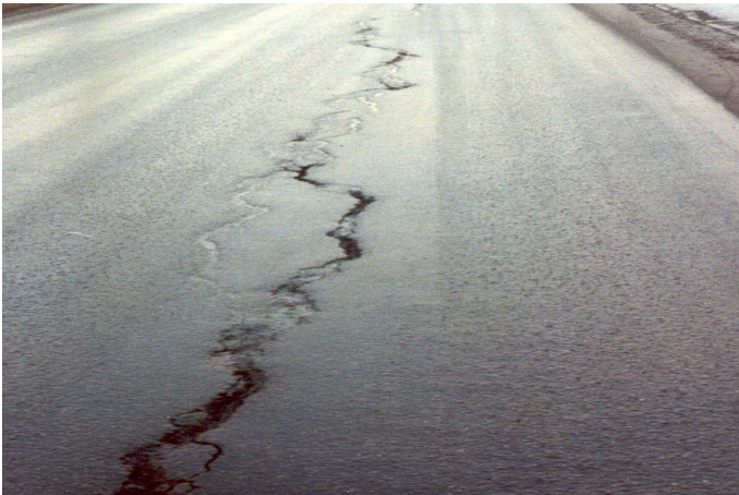
Figure 6. Fissuration du revêtement en raison du gel, Rælingen, Norvège
