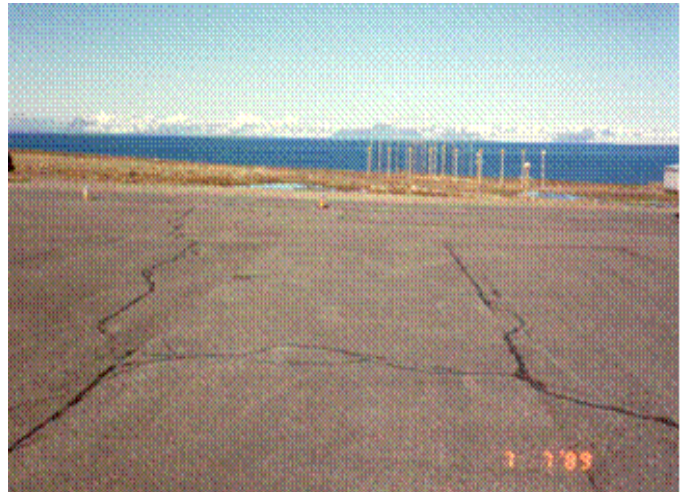
Figure 7. Remontée de fissures sur chaussée en béton, Svalbard, Norvège
