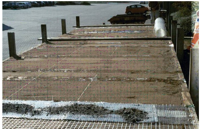
Figure 17. Installation de la géogrille dans la planche d'essai
