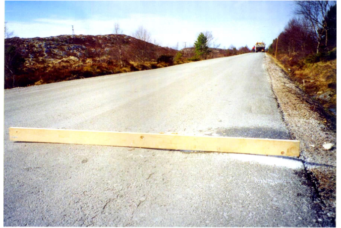
Figure 5. Orniérage de surface du revêtement en asphalte, Hitra, Norvège.
