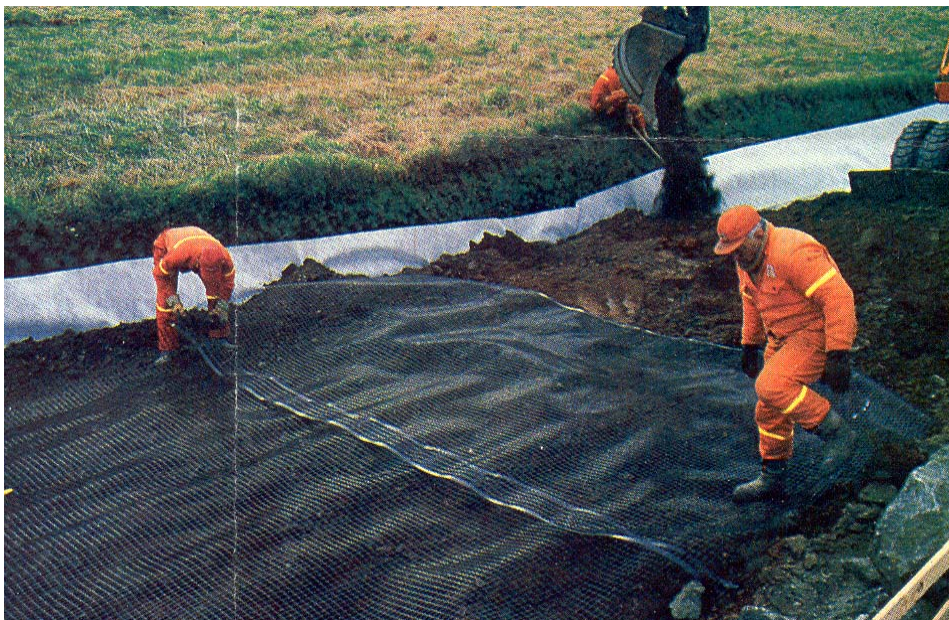
Figure 2. Installation de la géogrille de renforcement lors de la réhabilitation d'une route à Vesterålen, Norvège (Myhre, 1985).
