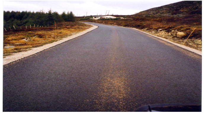
Figure 15. Hitra, Norvège. Route après installation du béton bitumineux.
