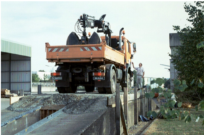
Figure 16. Planche d'essai, Allemagne (Wilmers et al., 2003)
