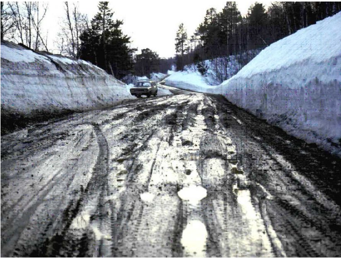
Figure 4. Route en matériau granulaire avec une capacité portante insuffisante, Snåsa, Norvège.
