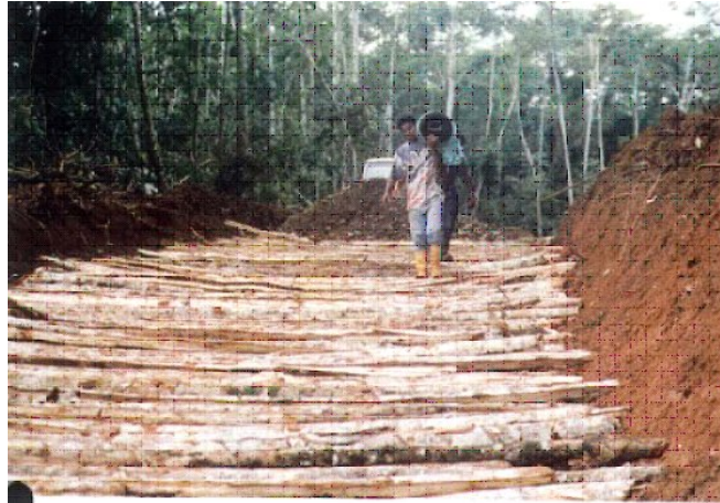
Figure 12. Des renforcements par géosynthétique sont apportés sur une route d'accès avec un renforcement en bois.
