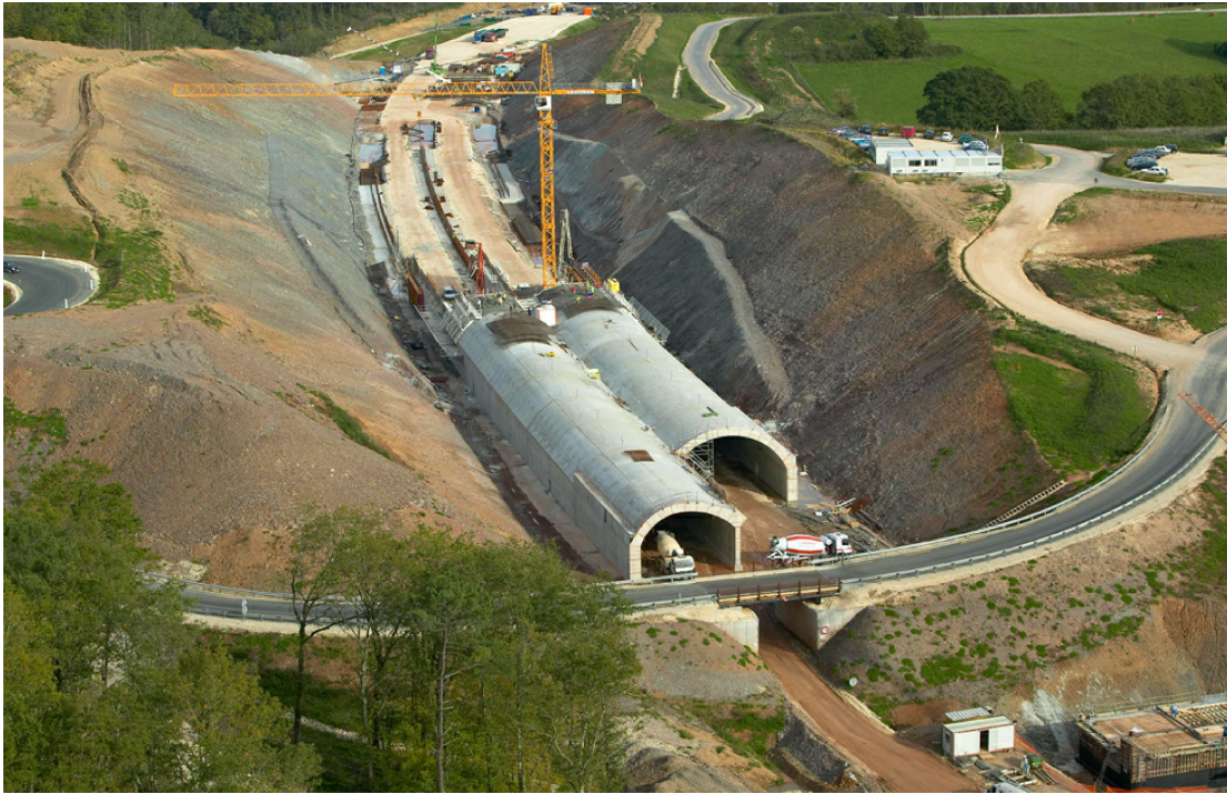
figure 1. Vue aérienne de la tranchée couverte de la crête
