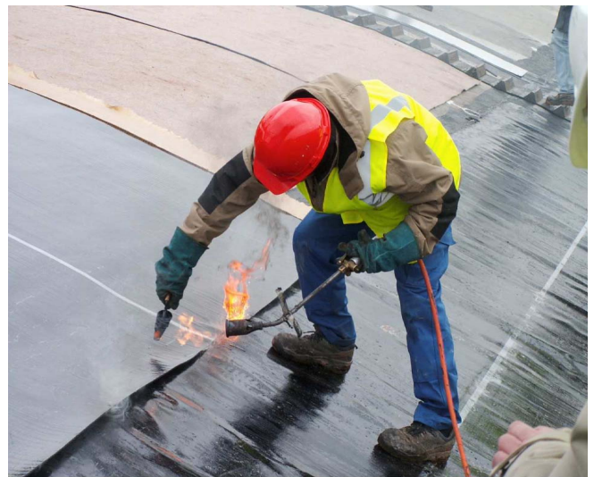
Figure 5. Soudure au chalumeau à propane
