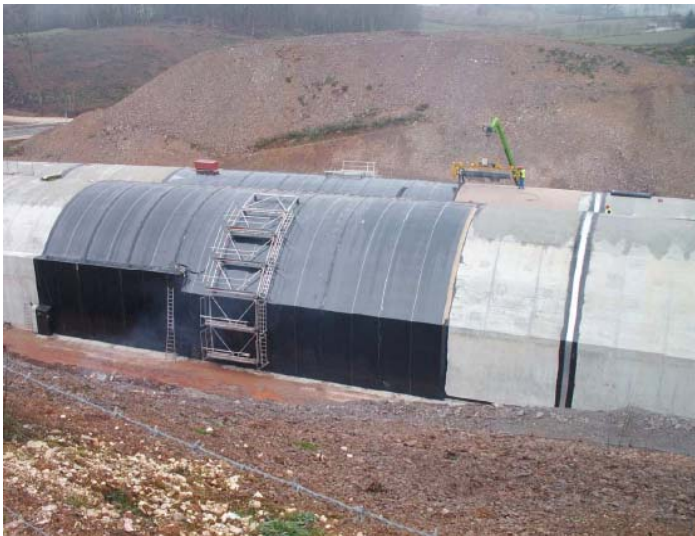
Figure 4. Déploiement transversal des lés par rapport à l'ouvrage
