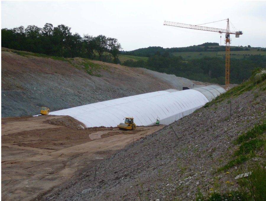
Figure 10 : Remblaiement de la tranchée
