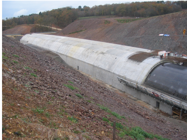
Figure 3. Coffrage de la voûte
