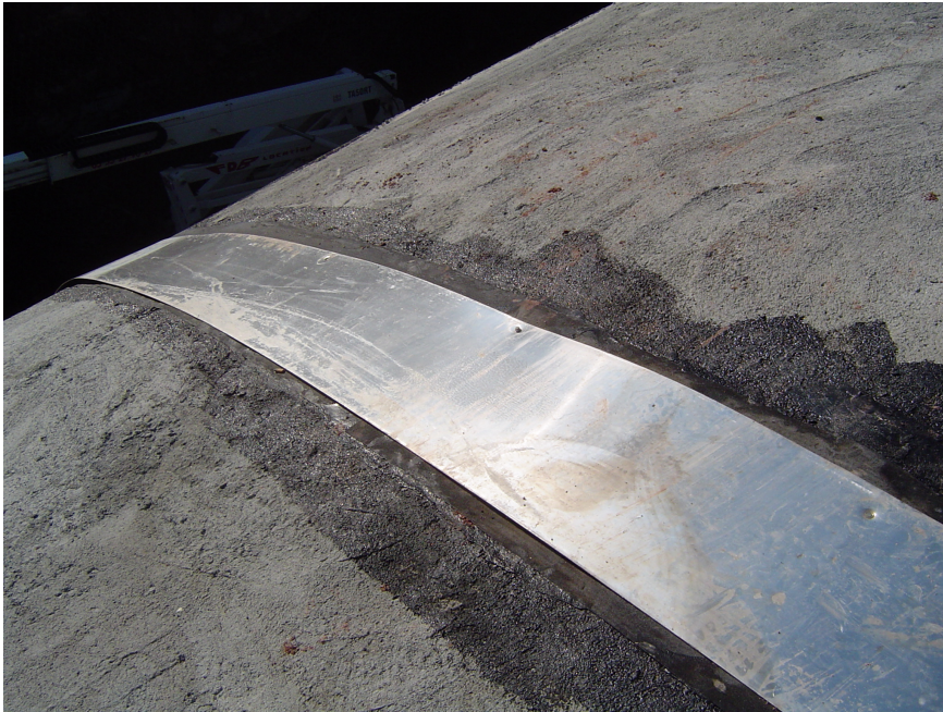
Figure 9. Traitement des joints actifs
