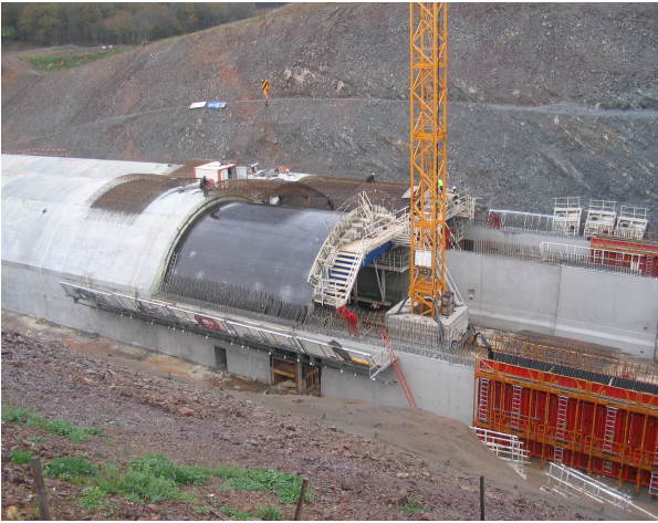
Figure 2. Coffrage des voiles verticaux
