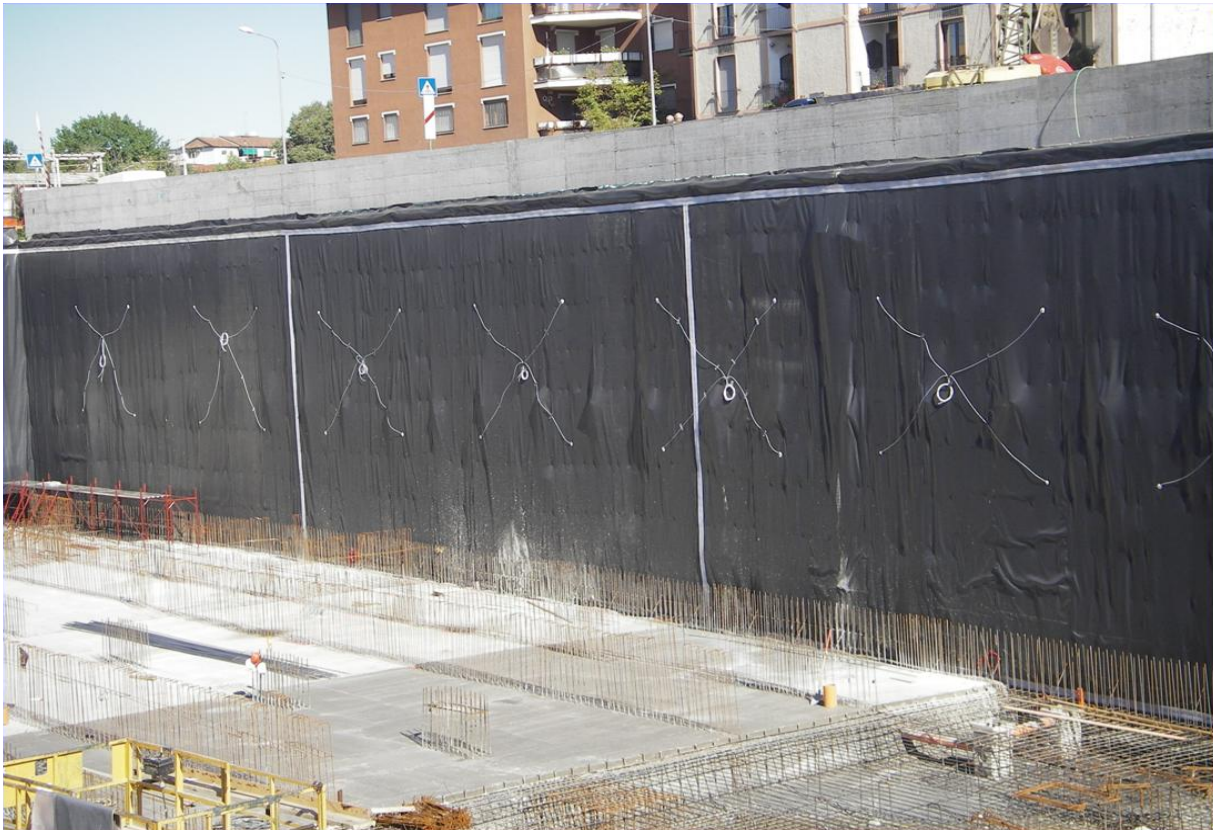
Figure 3. Étanchéité de soutènement en Italie avec dispositif d'injection
