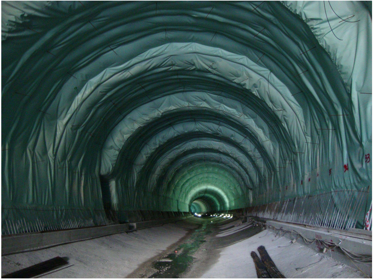
Figure 1. Tunnel ferroviaire en Grèce
