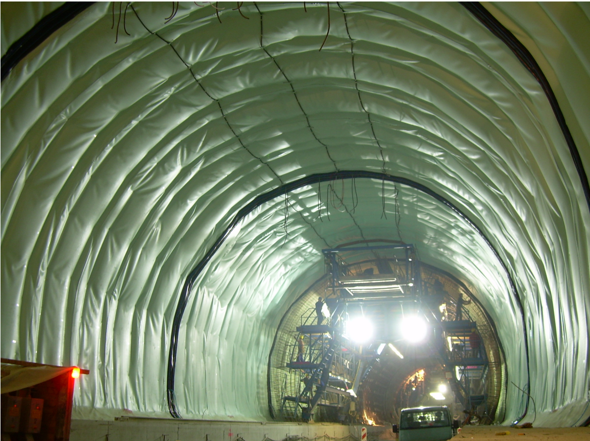
Figure 2. Tunnel avec compartimentage et tubes d'injection
