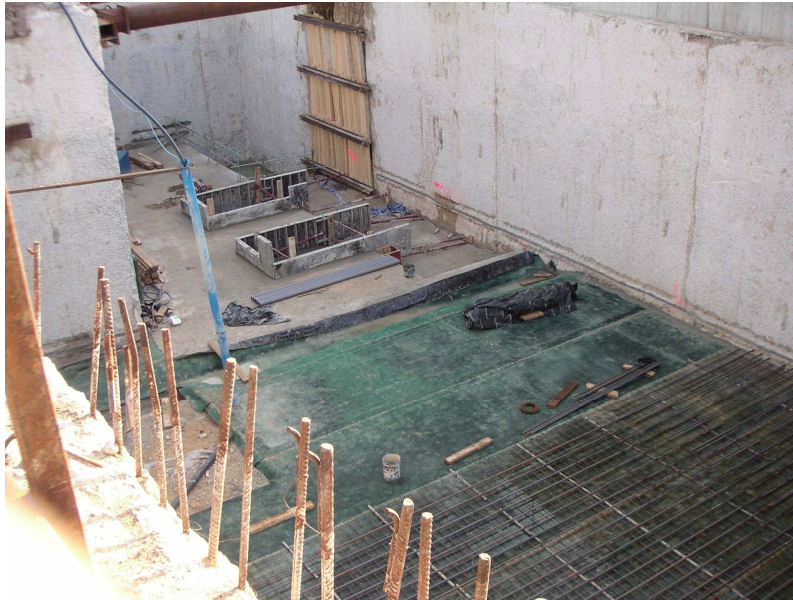
Figure 2. Étanchéité du radier – Ligne 13 métro Paris
