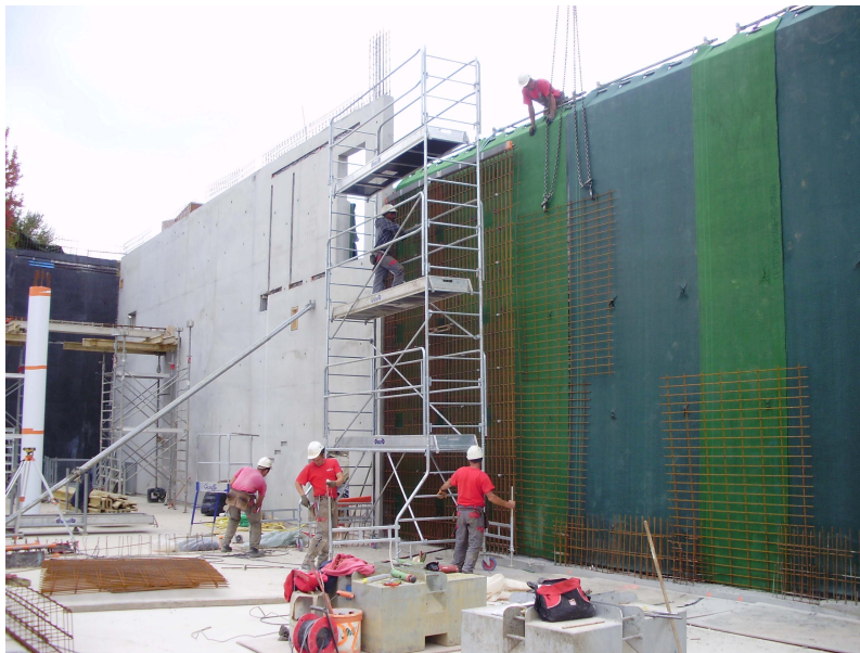
Figure 3. Étanchéité des pénétrations – Ligne 13 métro Paris
