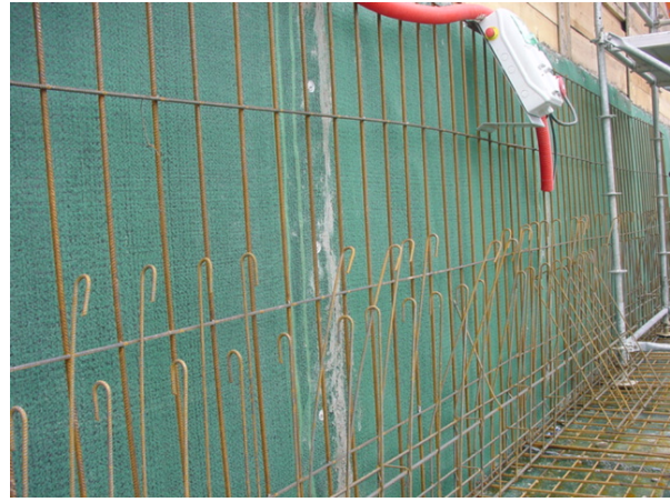
Figure 7. Pose GSB en piédroit d'ouvrage avec emprise (photo EGIS)
