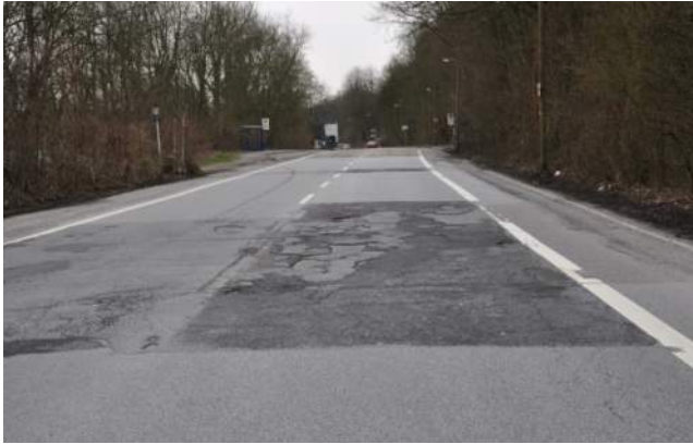
Figure 2 et 3. Illustration de fissures.
