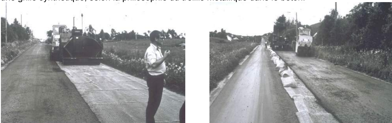
Figure 1. Première installation d'un renforcement d'enrobé à la fin des années 1960.
