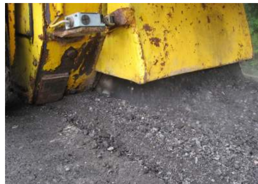
Fraisage env. 1 cm au dessus de la grille
