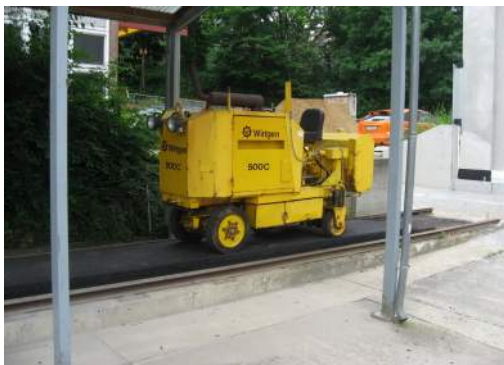
Mise en place de la fraiseuse
