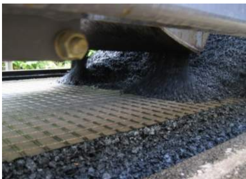
Mise en œuvre de la couche de roulement (4 cm compacté)
