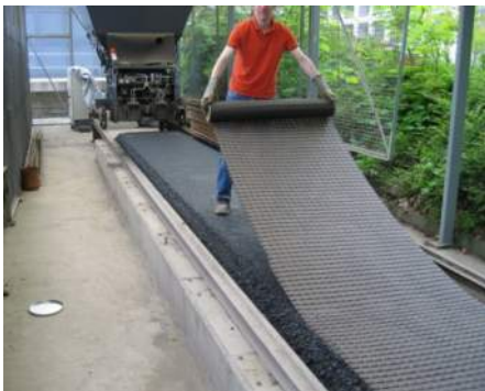
Mise en œuvre de la grille en polyester
