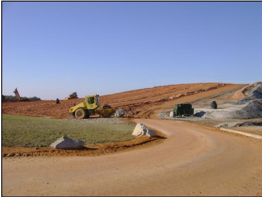
Figure 5. Mise en œuvre de la couverture sur le dôme de déchets stabilisés
