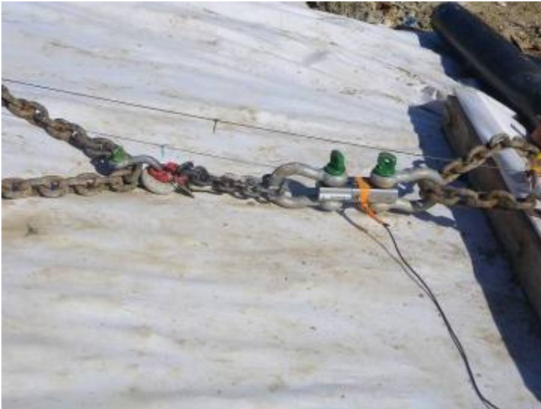
Figure 6. Planche d'essai n°1. Mise en place du capteur de force sur manille reliée au portique
