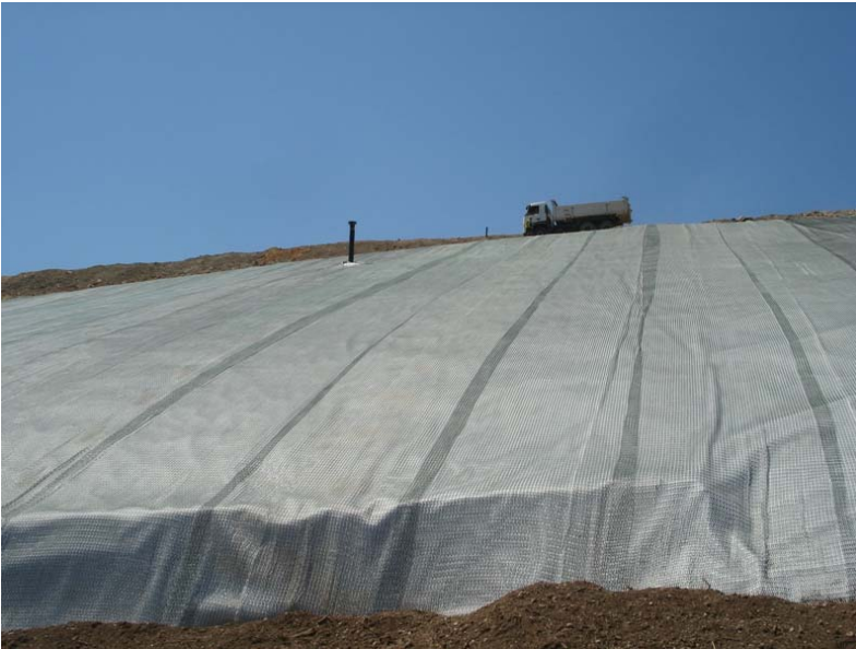
Figure 9. Mise en œuvre d'une nappe d'accrochage sur l'un des sites.
