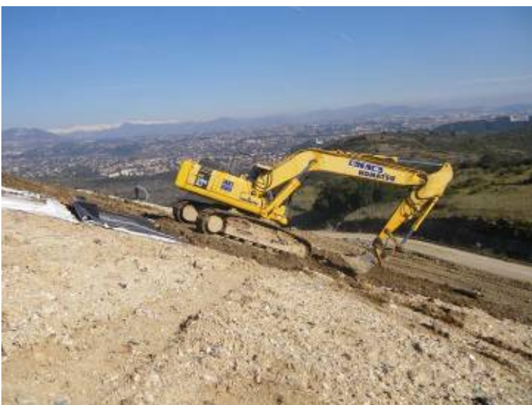
Figure 8. Planche d'essai n°1. Circulation de la pelle hydraulique.
