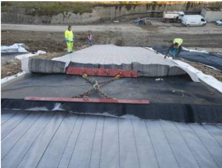
Figure 7. Planche d'essai n°2. Mise en place des portiques.
