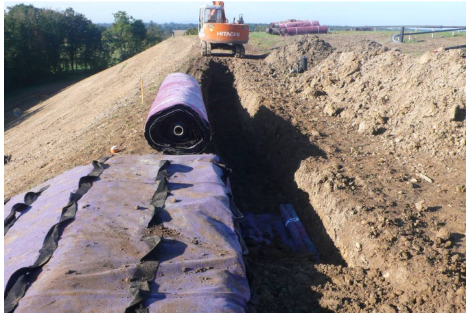
Figure 6. Ancrage du géocomposite dans la tranchée sommitale.
