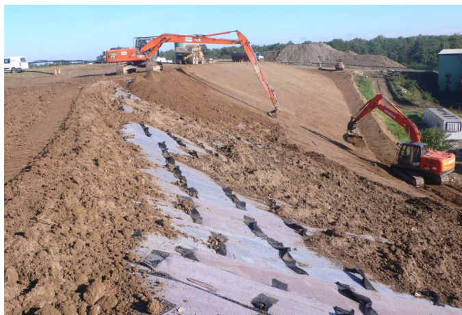
Figure 5. Mise en place des matériaux sur le géocomposite à l'aide d'une pelle long bras.
