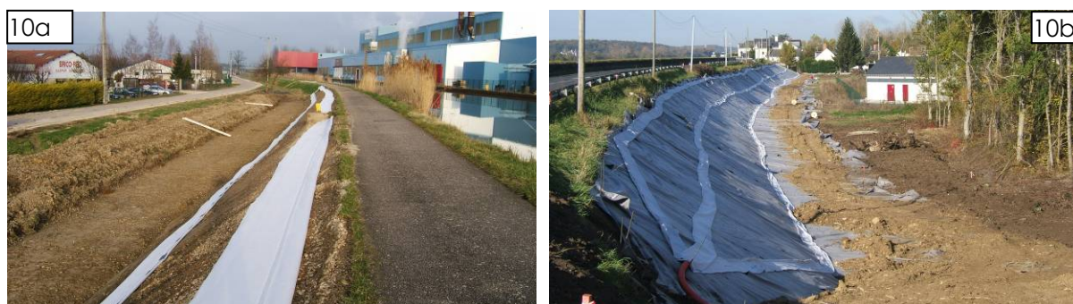
Figure 11. Installation de bandes du capteur géotextile à fibres optiques sur la digue du canal de la Marne au Rhin (a) et sur les digues de protection contre les inondations de la Loire / Authion (b).
