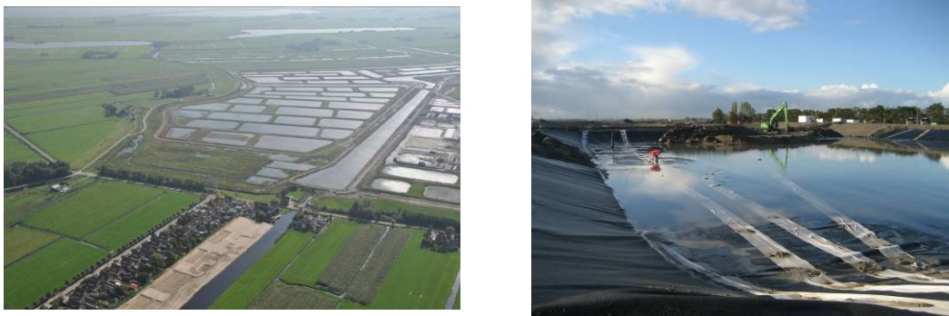
Figure 14. Volgermeer polder (NL) – Vue aérienne à gauche. Vue du bassin étanché par géomembrane et instrumenté avec les bandes du capteur à fibres optiques à droite.
