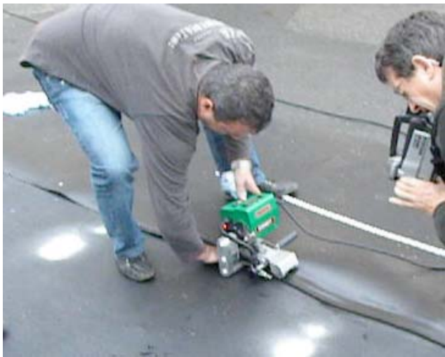
Figure 10. Vue de la machine en cours de soudage et de l'acquisition des images thermographiques
