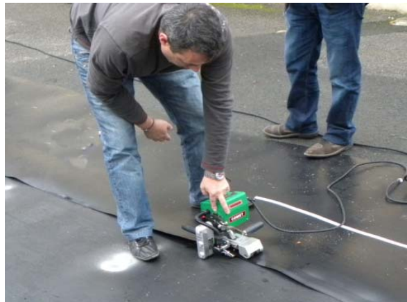
Figure 8. Vue de la même machine pendant le soudage d'un corps d'épreuve en PEHD
