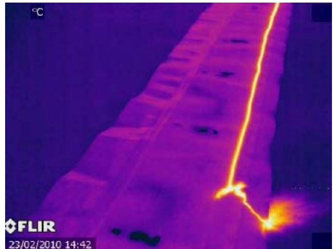
Figure 20. Vue infrarouge de la géomembrane et d'une fuite de diamètre 1mm
