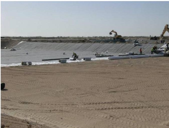
Figure 12. Mise en œuvre de la géomembrane bitumineuse de 4m sur géotextile
