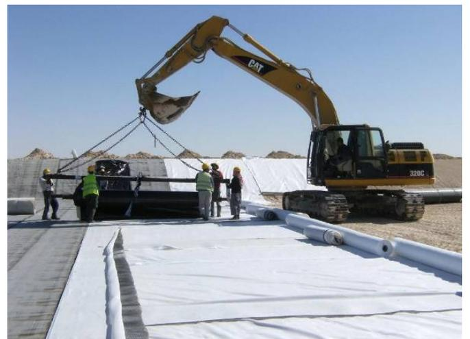
Figure 14. Déroulage des rouleaux à l'aide d'un palonnier
