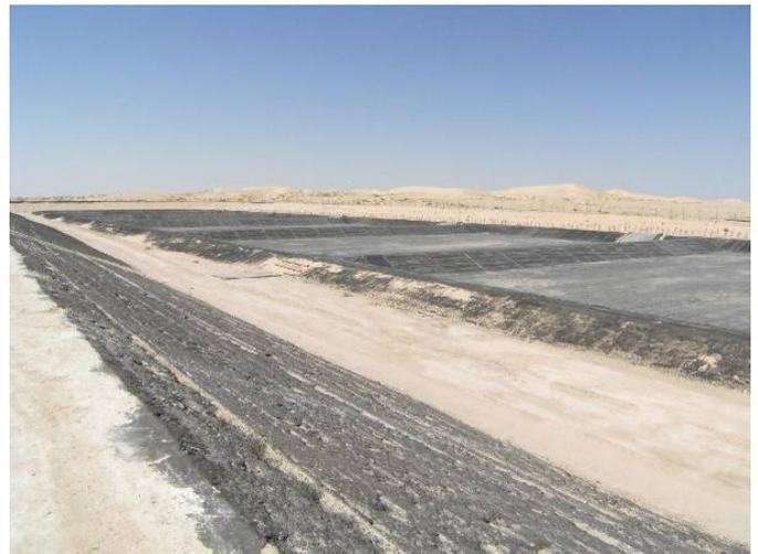
Figure 13. Tranchée d'ancrage en haut de talus
