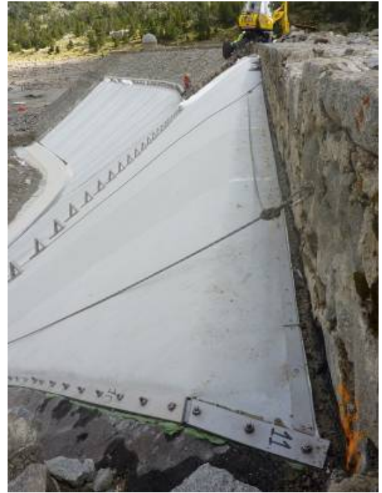
Figures 8. (a) Fixation périphérique en pied, et (b) au couronnement et à la limite latérale en rive droite.
