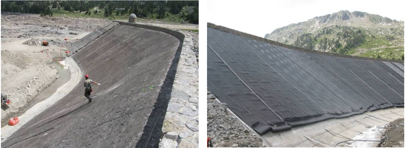
Figures 6. (a) Installation des profilés en U et (b) mise en place du géodrain dans les compartiments supérieurs.
