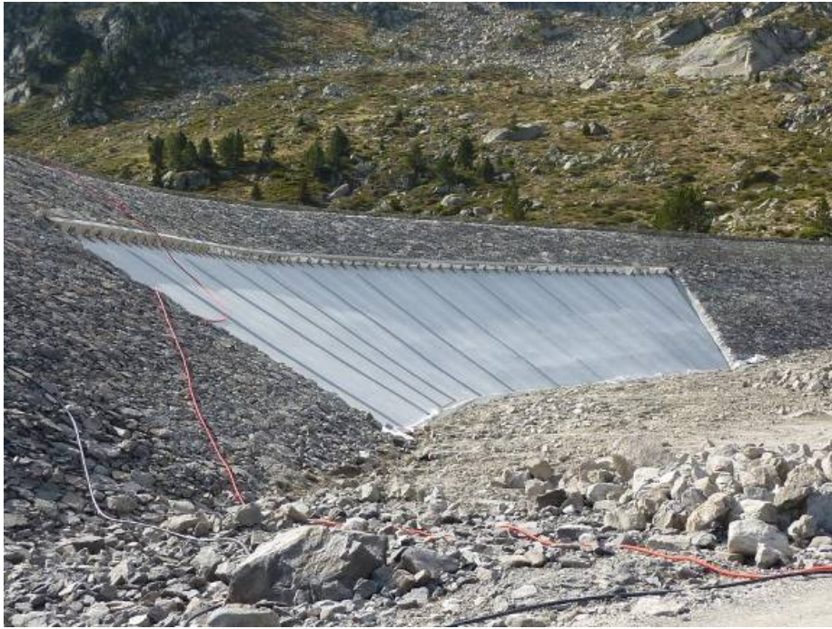
Figure 9. Vue du barrage à l'achèvement des travaux.
