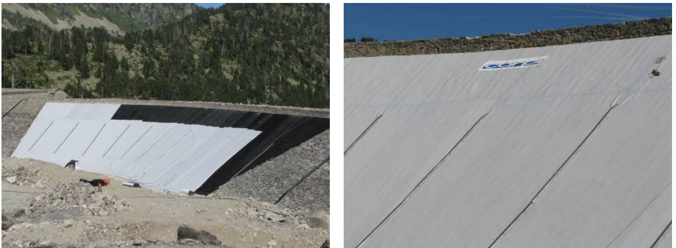
Figures 7. (a) Installation du géocomposite sur le géodrain et (b) le deuxième profilé du système achève un parfait tensionnement des lés.
