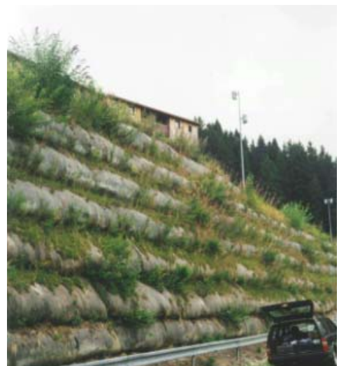
Figure 1. Mur construit en 1977 à Prapoutel-les-Sept-Laux (+1350 m) dans les Alpes (Nappes de Stabilenka® 200 - 33 ans après. Le parement additionnel n'a jamais été construit).
