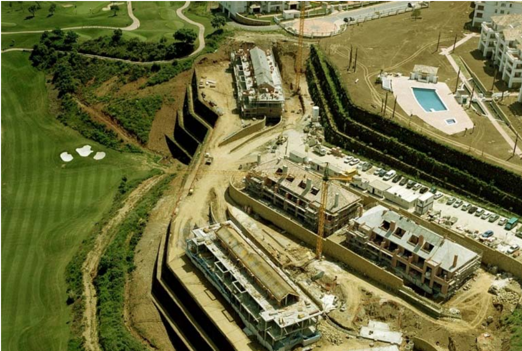
Figure 5. Vue d'ensemble du projet, Mijas, Espagne
