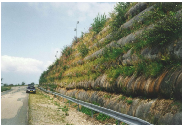
Figure 1. Mur construit en 1977 à Prapoutel-les-Sept-Laux (+1350 m) dans les Alpes (Nappes de Stabilenka® 200 - 33 ans après. Le parement additionnel n'a jamais été construit).
