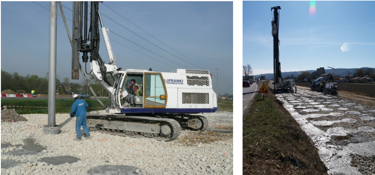
Figure 6. Réalisation des inclusions
