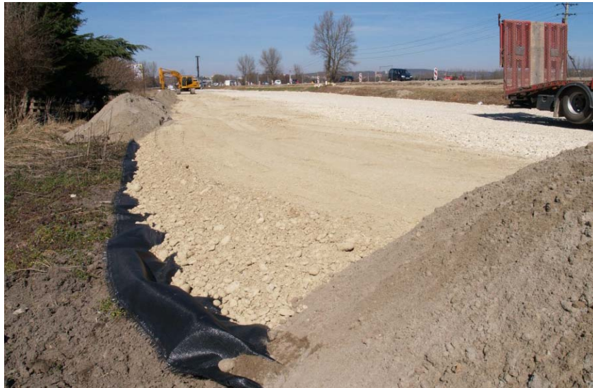
Figure 5. Plateforme de travail
