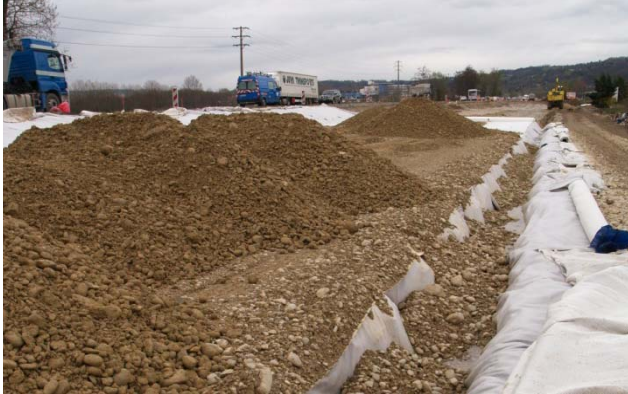
Figure 10a. Remblaiement et remplissage de la tranchée
