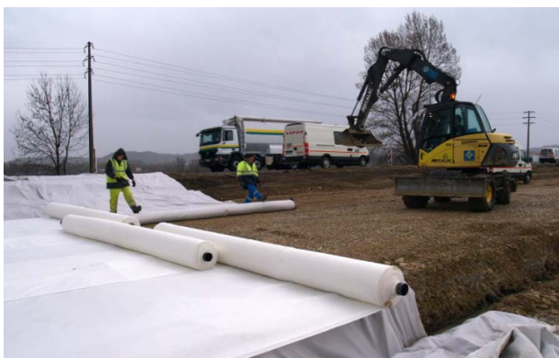
Figure 9a. Installation en sens travers
