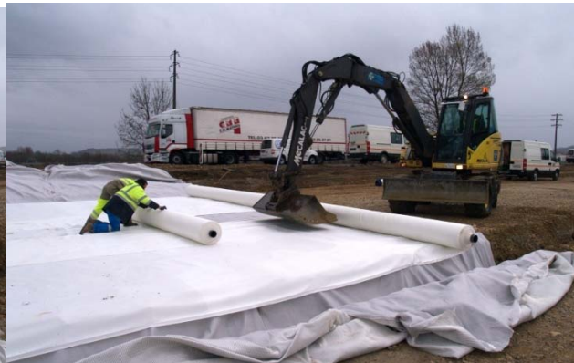
Figure 9b. Mise en œuvre sens longitudinal
