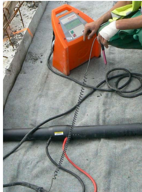
Figure 5. Collecteur drain et manchon de connexion
