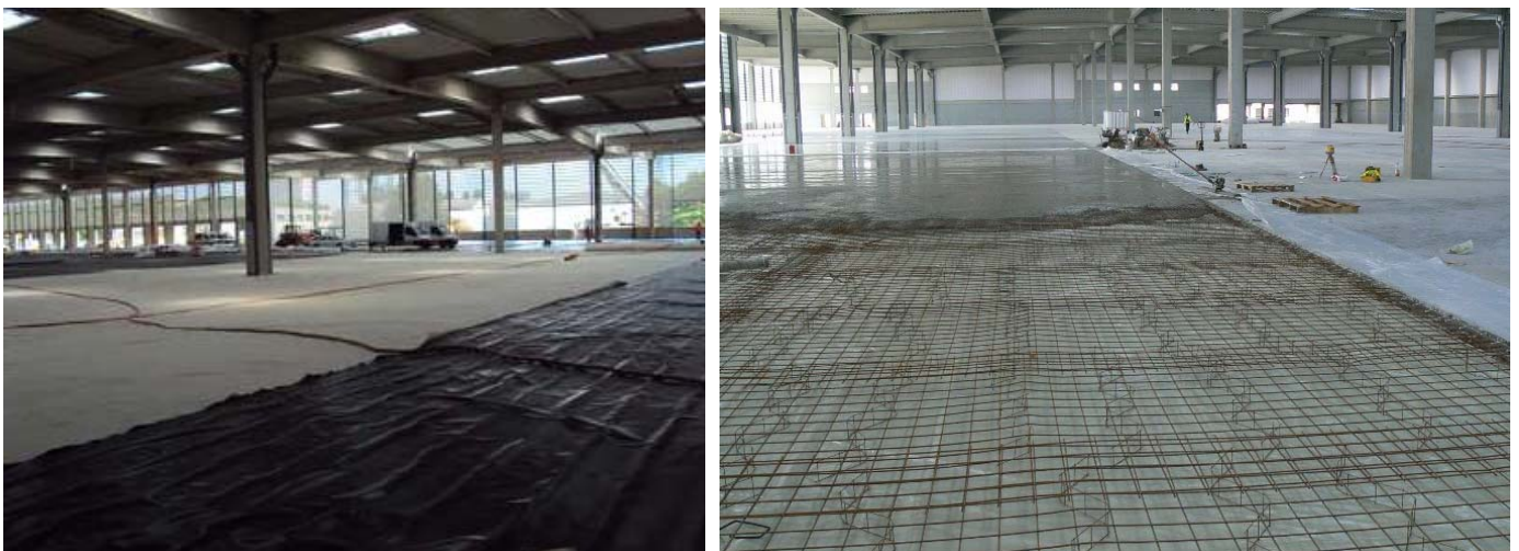
Figure 11. Pose du géotextile de protection et ferrailage
