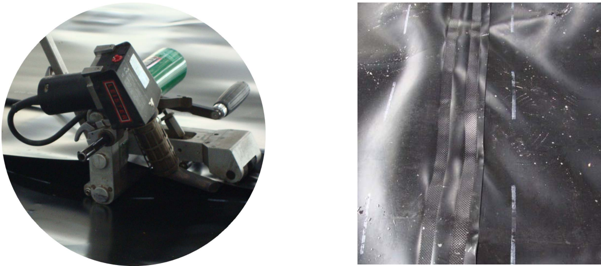
Figure 6. Soudure géomembrane et Canal Central
