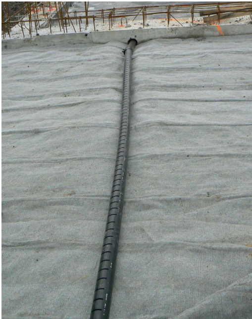
Figure 5. Collecteur drain et manchon de connexion
