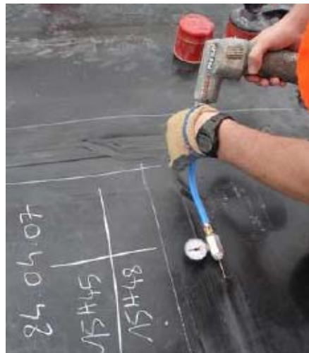
Figure 7. Contrôle de soudure
