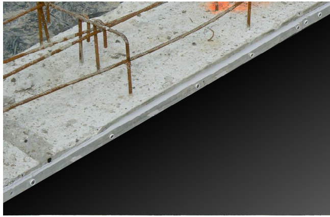
Figure 9. Fixation mécanique sur voiles
